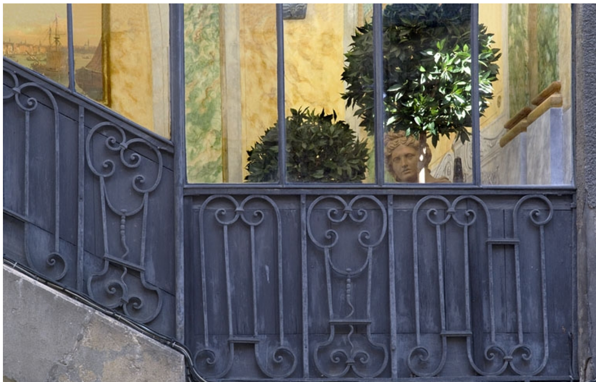
Escalier à cage ouverte sur cour : détail de la rampe en fer forgé.
