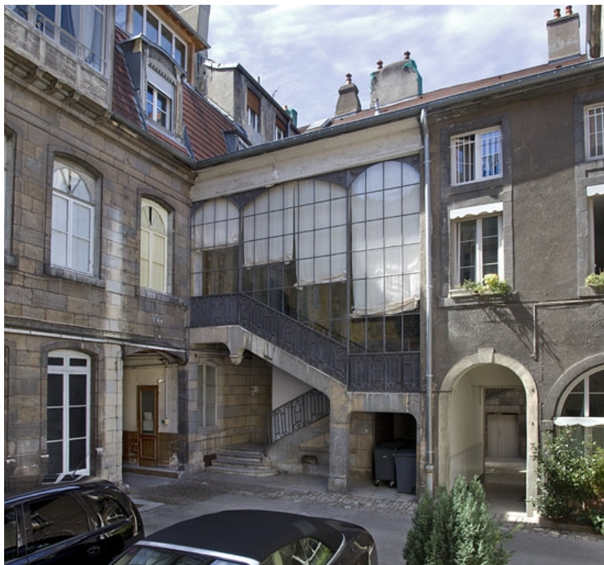
Vue d'ensemble de l'escalier à cage ouverte, de trois quarts droit.
