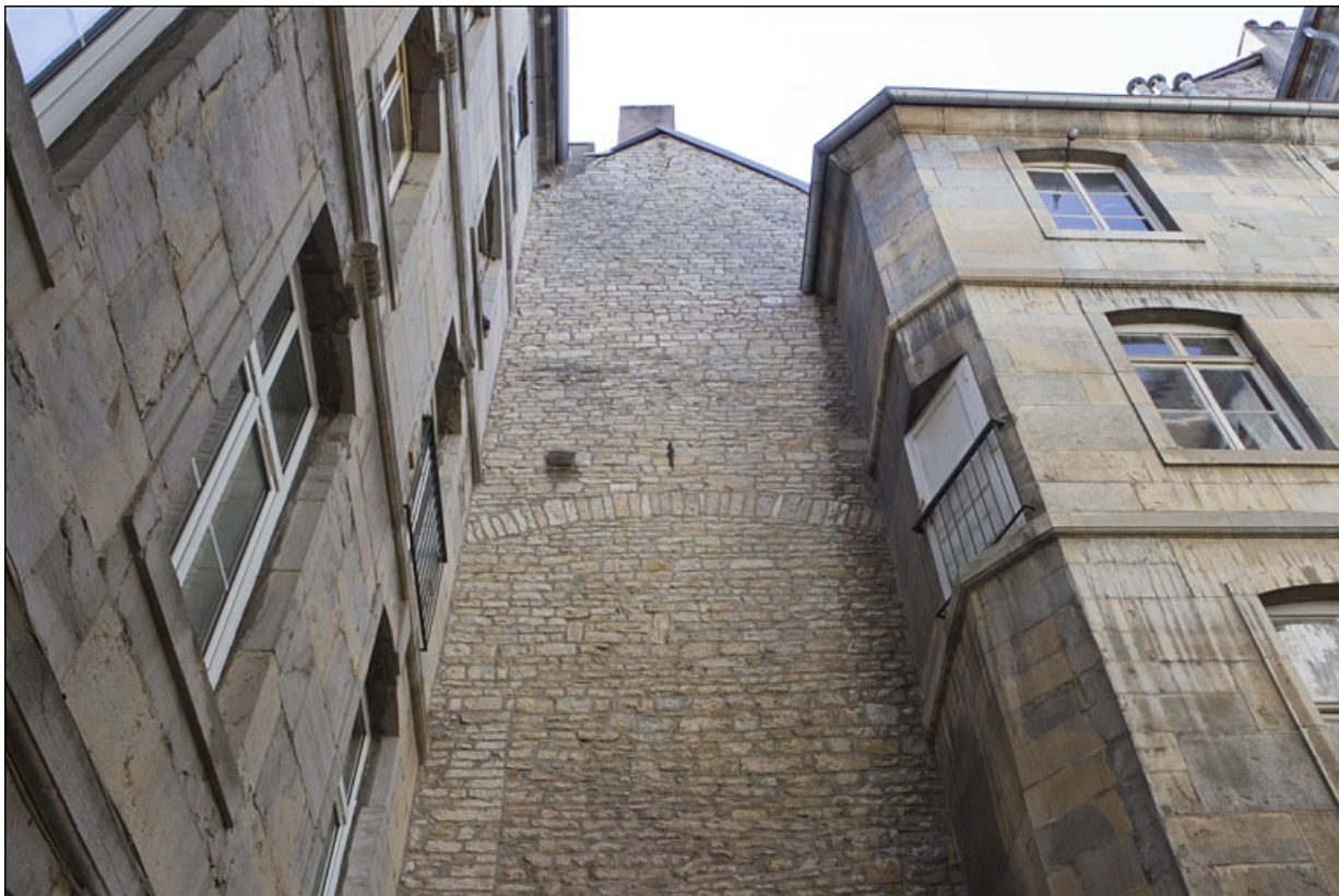
Première cour, à droite : détail du mur mitoyen de la maison voisine.
