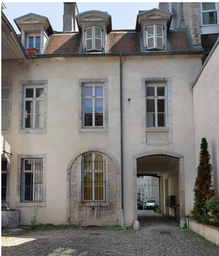
Vue d'ensemble de la façade postérieure du premier logis secondaire. 25, Besançon, 50 rue des Granges, lieudit : îlot Saint-Pierre
