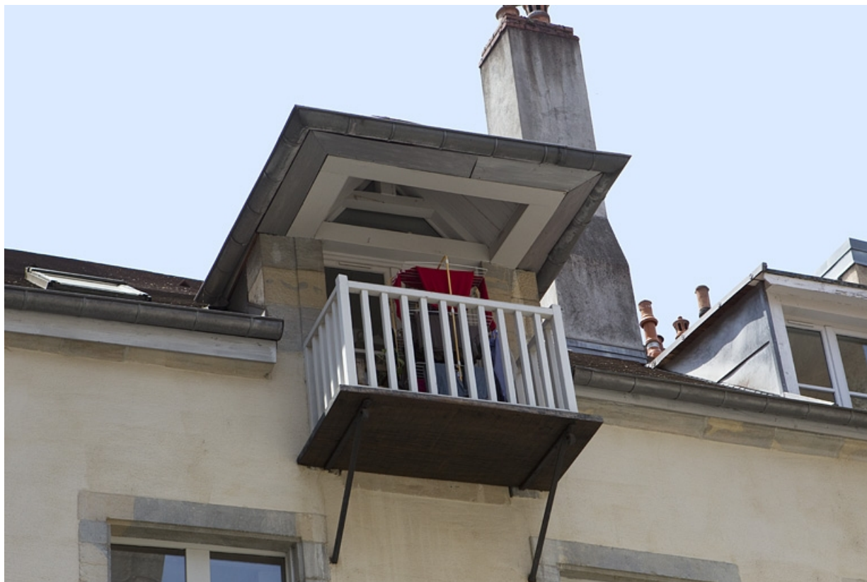
Logis secondaire au fond de la deuxième cour : détail de l'ancienne lucarne du grenier.
