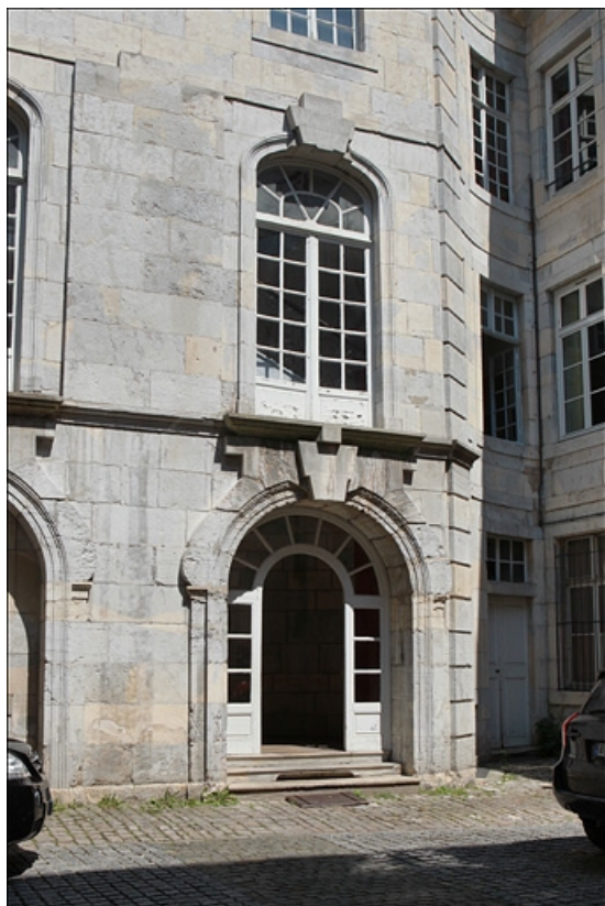
Logis principal, aile de l'escalier : détail de la porte d'entrée.
