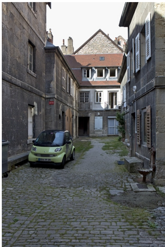
Vue d'ensemble des bâtiments depuis l'entrée de la cour.
