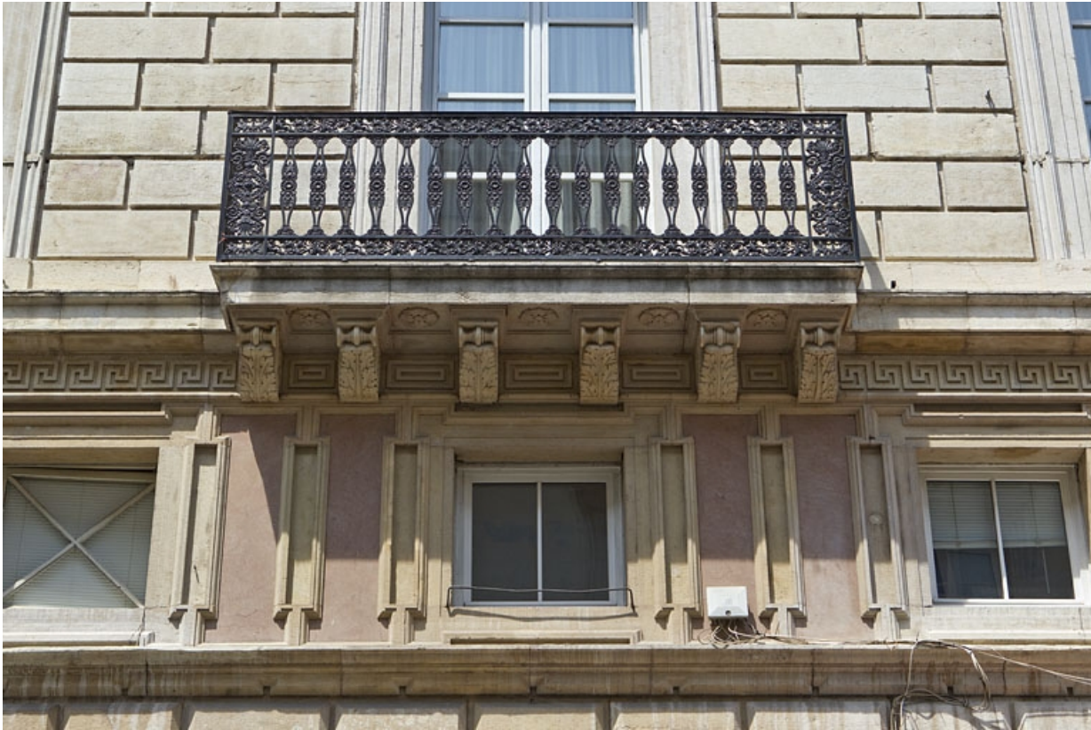
Façade antérieure : détail de l'entresol et du balcon.
