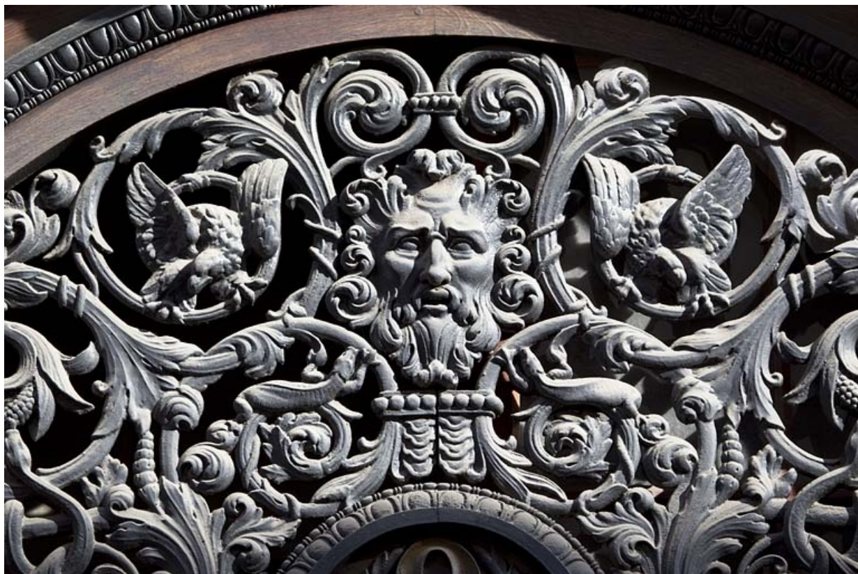
Portail d'entrée : détail du décor en fonte du tympan.
