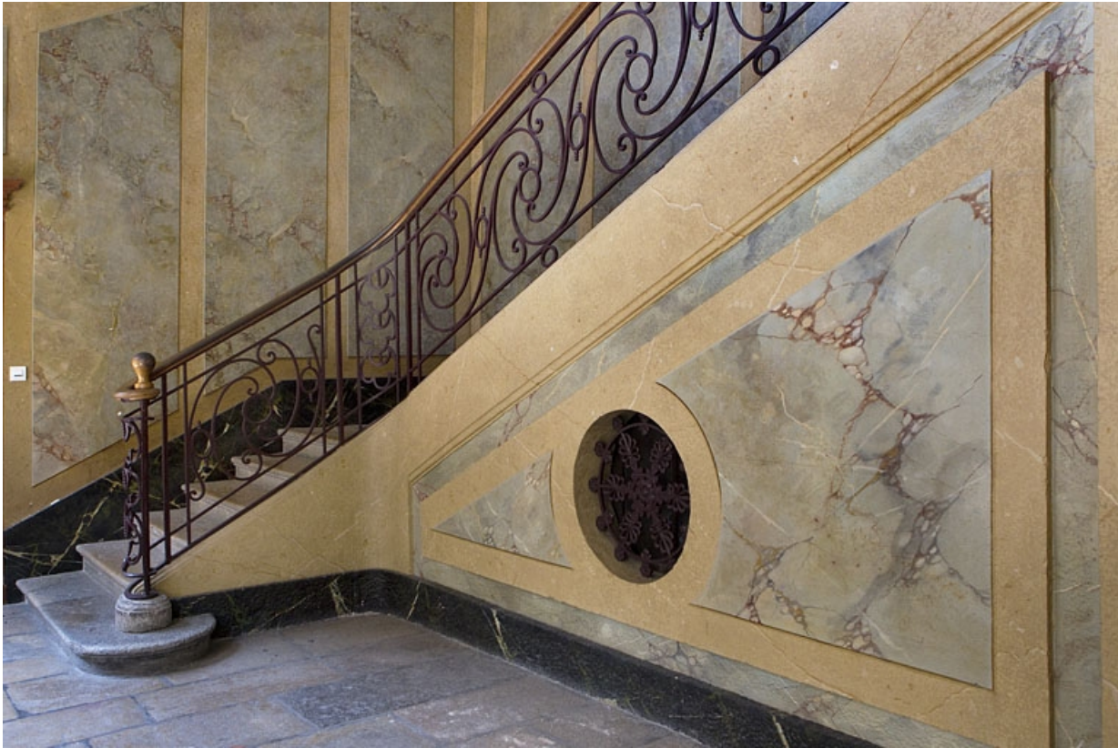
Logis principal, escalier : détail du mur d'échiffre.
