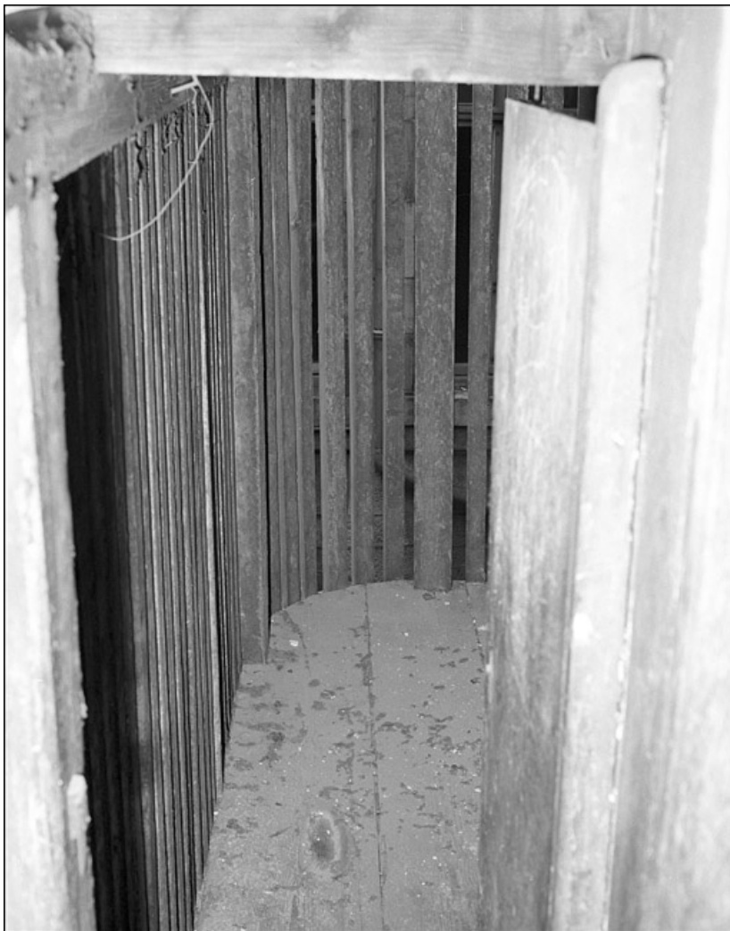
Détail de l'intérieur du bûcher.
