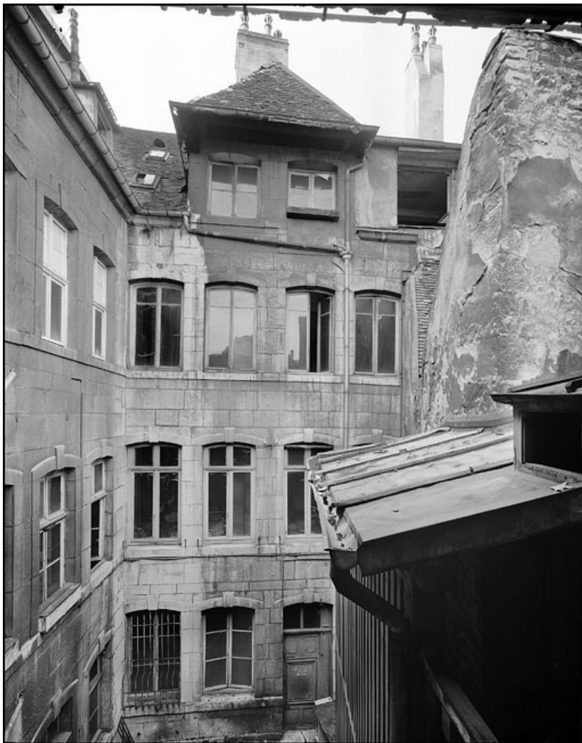
Vue d'ensemble des bâtiments détruits depuis le fond de la deuxième cour, de face. 25, Besançon Grande Rue 67, lieudit : îlot Saint-Pierre
