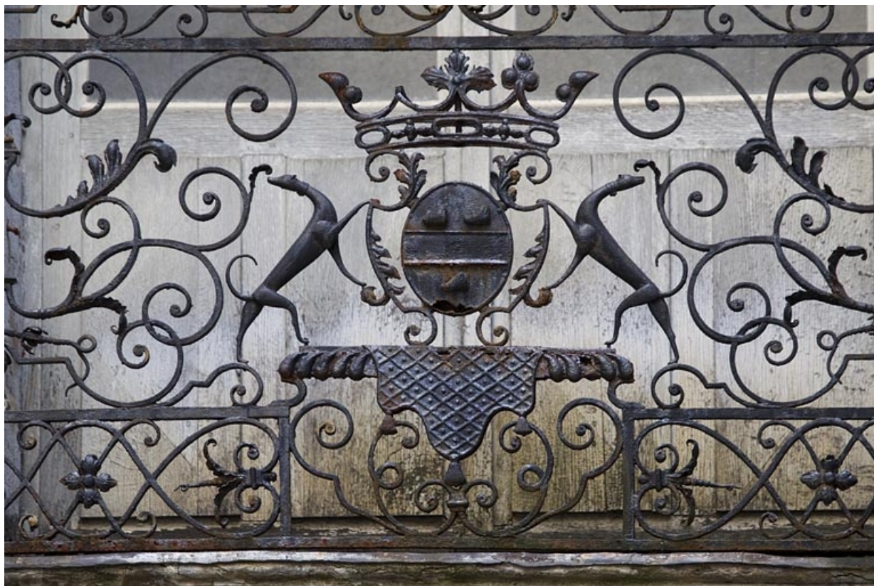
Façade antérieure en fond de cour : détail des armoiries, balcon du premier étage.
