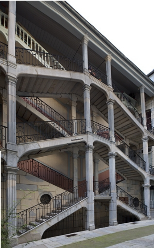
Vue d'ensemble de l'escalier à cage ouverte de trois quarts gauche.
