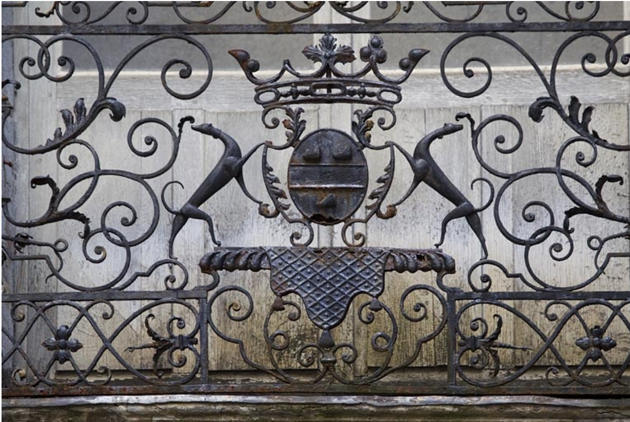
Façade antérieure en fond de cour : détail des armoiries, balcon du premier étage. 25, Besançon Grande Rue 67, lieudit : îlot Saint-Pierre
