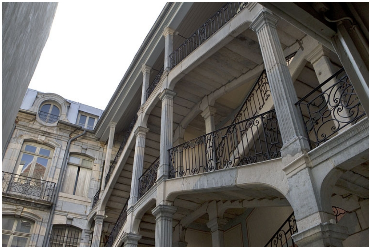
Escalier à cage ouverte : détail de la partie supérieure, de trois quarts droit.
