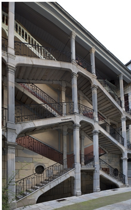
Vue d'ensemble de l'escalier à cage ouverte de trois quarts gauche.
