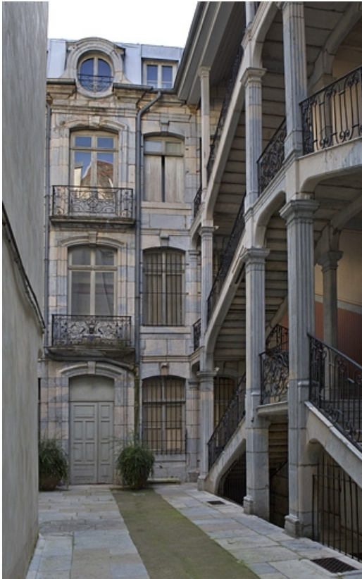
Vue d'ensemble de la façade en fond de cour, de face.
