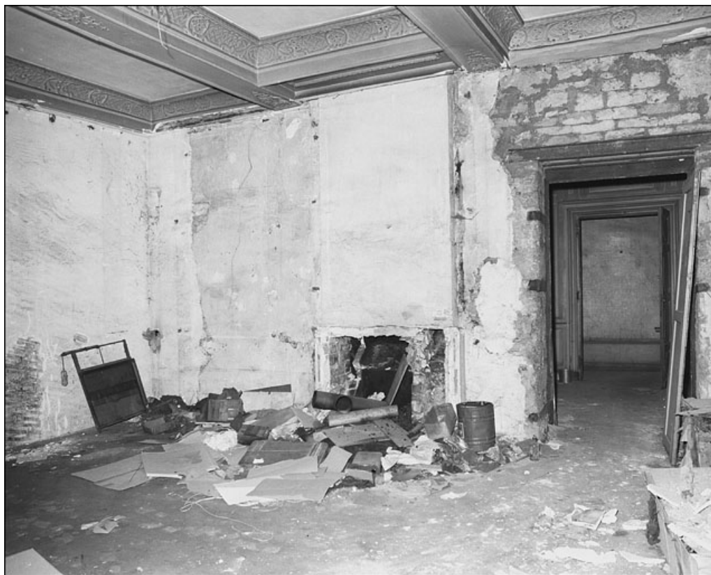
Intérieur : détail de l'angle d'une pièce avec le plafond.
