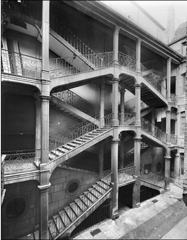
Vue d'ensemble de l'escalier à cage ouverte depuis le fond de la cour.
