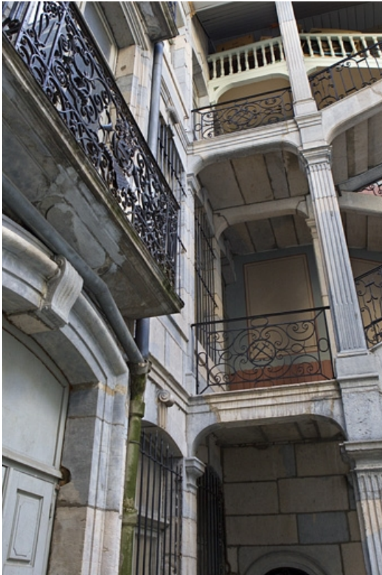
Escalier à cage ouverte : détail de la travée contre la façade du logis en fond de cour. 25, Besançon Grande Rue 67, lieudit : îlot Saint-Pierre
