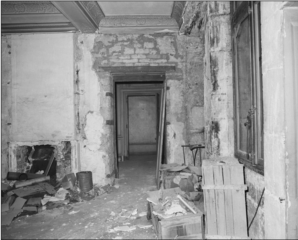
Intérieur : détail d'une pièce avec la porte d'entrée. 25, Besançon Grande Rue 67, lieudit : îlot Saint-Pierre
