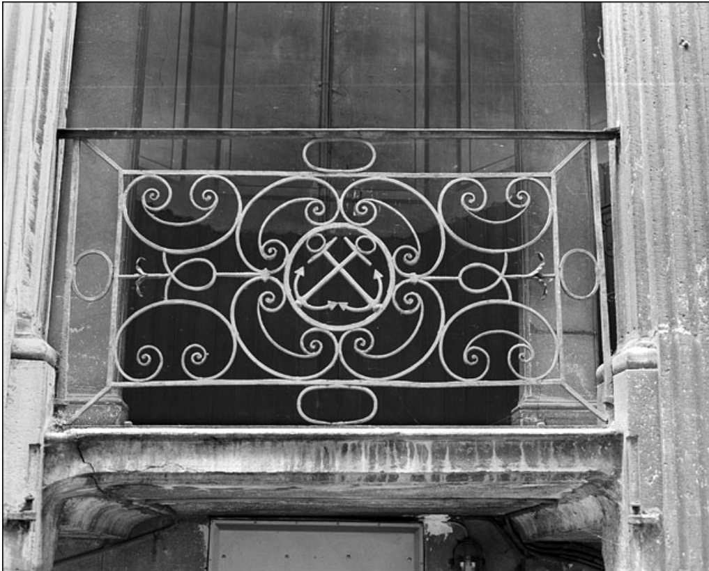
Escalier à cage ouverte : détail d'un panneau de ferronnerie, de face.
