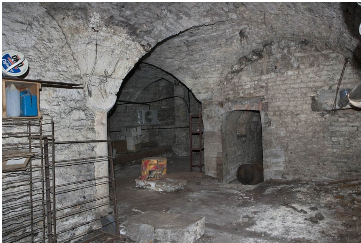
Logis principal, sous-sol : cave A, vue d'ensemble.
