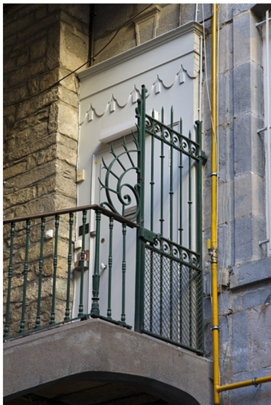
Logis principal : détail de la porte du premier étage sur la façade postérieure. 25, Besançon Grande Rue 53, lieudit : îlot Bouteiller
