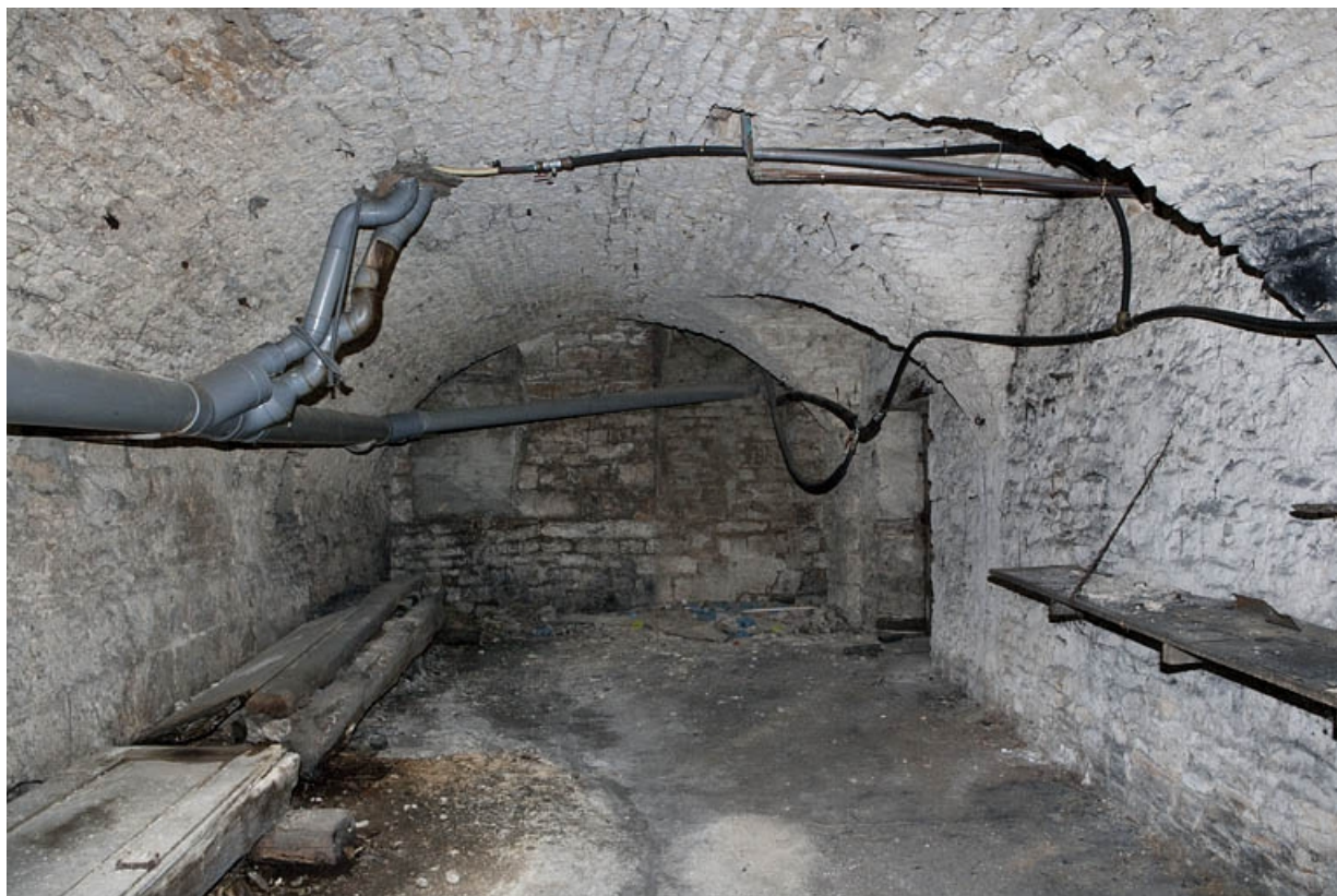
Logis principal, sous-sol : cave C, partie gauche. 25, Besançon Grande Rue 53, lieudit : îlot Bouteiller
