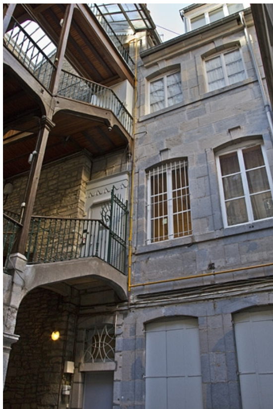
Façade postérieure du logis principal : vue d'ensemble.
