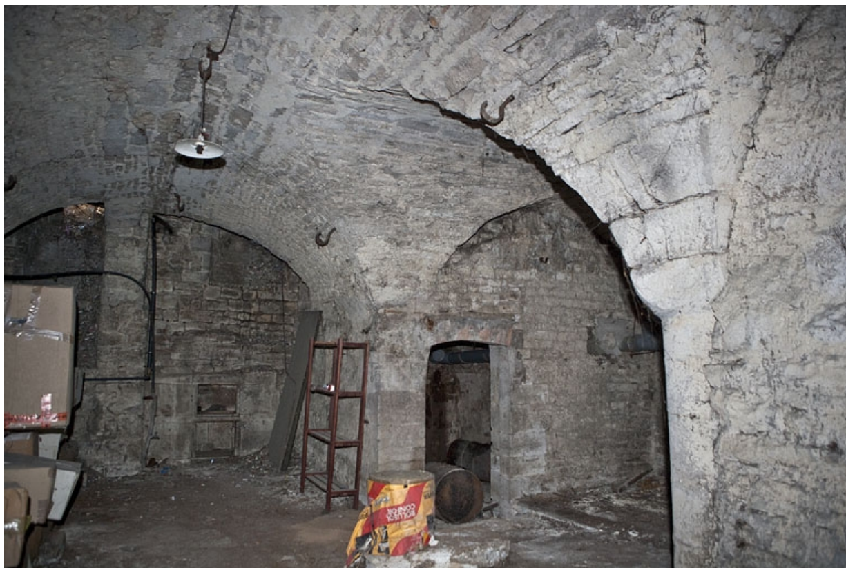
Logis principal, sous-sol : cave A depuis le fond de trois quarts droit.
