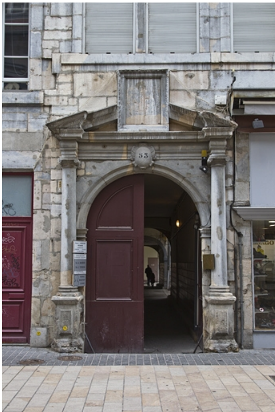
Façade antérieure du logis principal : portail d'entrée, de face.
