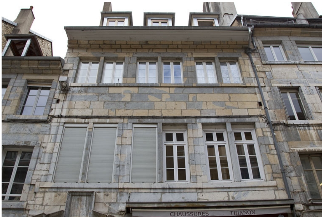
Façade antérieure du logis principal : détail des étages.
