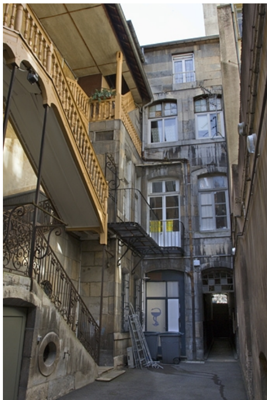
Vue d'ensemble de la façade postérieure du logis principal.
