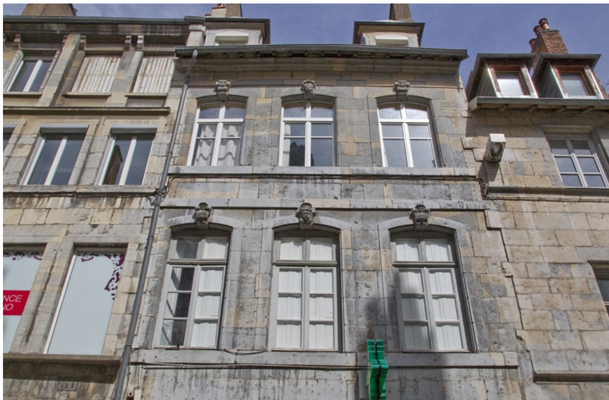
Logis principal : détail de la façade antérieure depuis le premier étage, de face. 25, Besançon Grande Rue 33, lieudit : îlot Bouteiller
