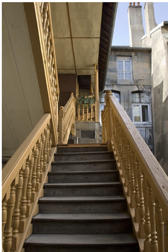
Première cour, escalier à cage ouverte : détail des dernières volées avec une rampe à balustres de bois tourné. 25, Besançon Grande Rue 33, lieudit : îlot Bouteiller
