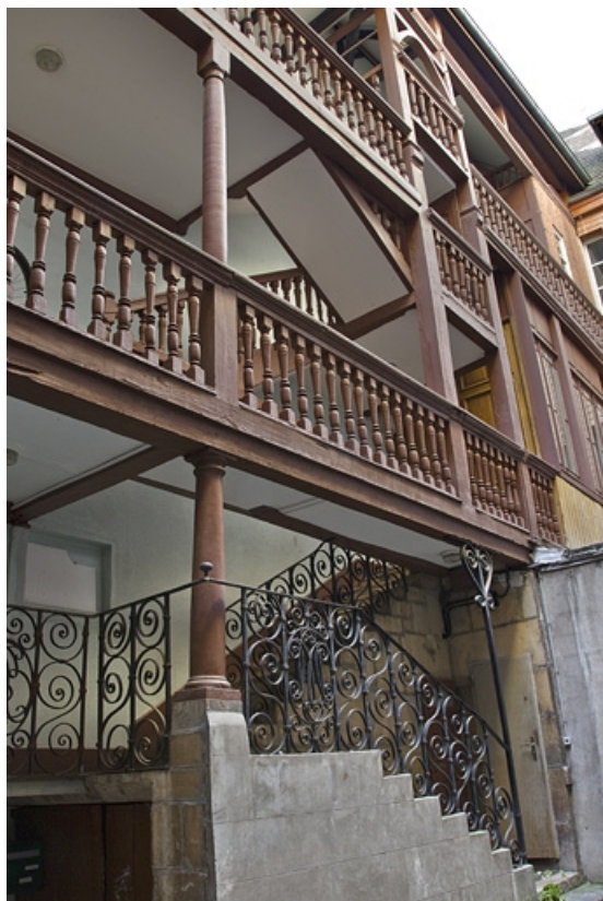
Première cour, escalier à cage ouverte : vue d'ensemble.
