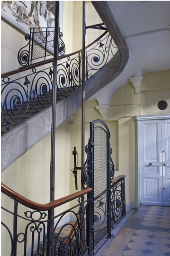
Aile droite, escalier : vue d'ensemble de la rampe en fer forgé.
