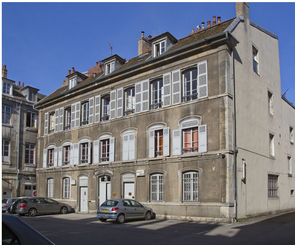
Maison à gauche de la deuxième cour : vue d'ensemble, de trois quarts droit. 25, Besançon Grande Rue 49, lieudit : îlot Bouteiller
