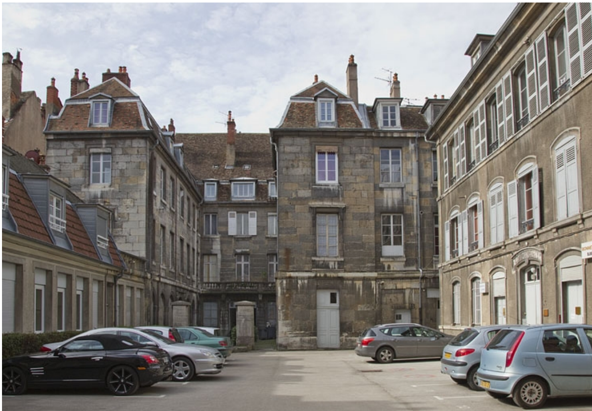
Logis principal : vue d'ensemble depuis le fond de la cour, de face. 25, Besançon Grande Rue 49, lieudit : îlot Bouteiller
