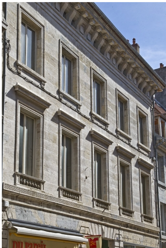
Façade antérieure, de trois quarts gauche : détail des premier et deuxième étages.
