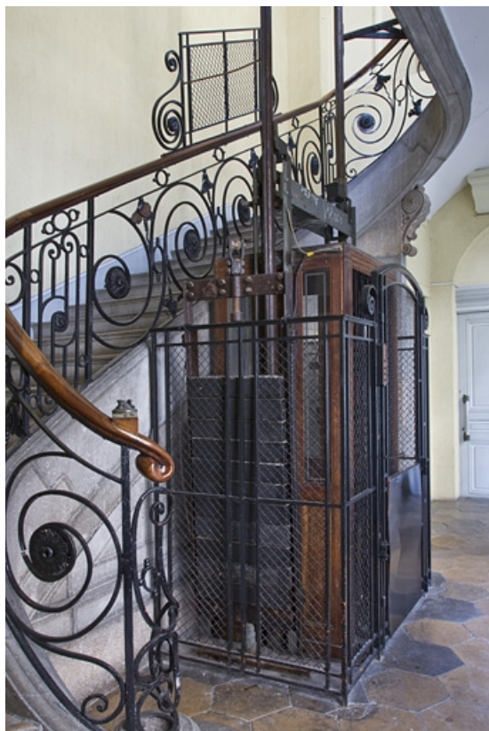
Aile droite : détail du départ de l'escalier et de l'ascenseur, vue rapprochée.
