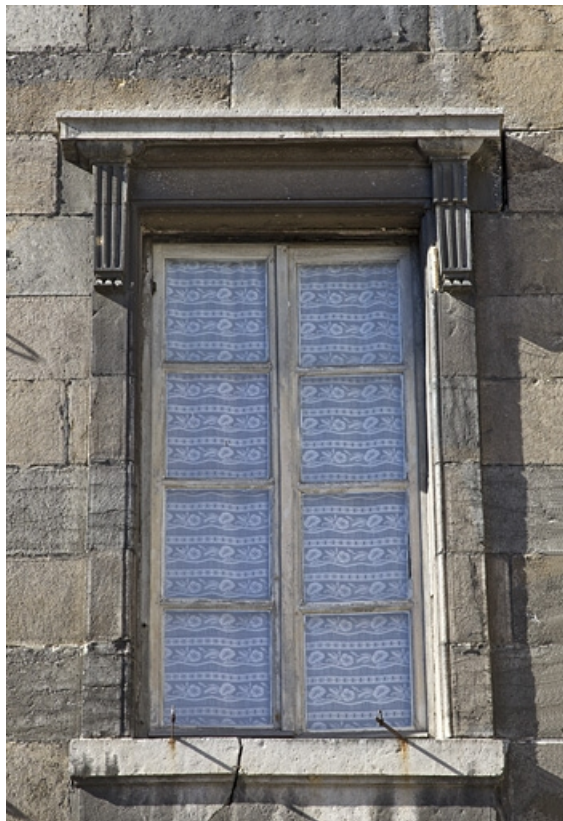
Aile droite : détail d'une fenêtre, de face.
