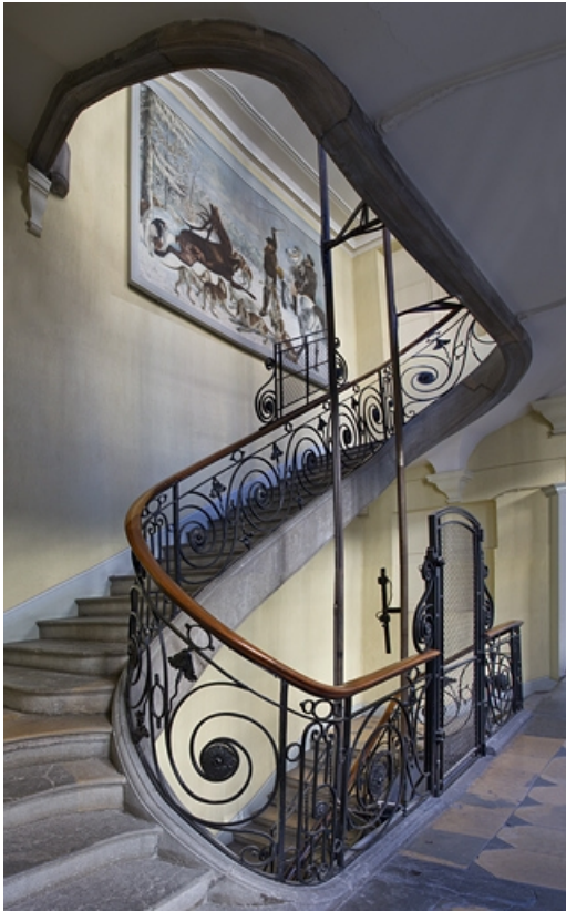
Aile droite : vue d'ensemble de la cage d'escalier depuis le premier étage.
