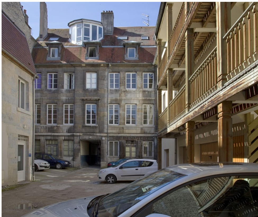
Logis principal : vue d'ensemble de la façade postérieure, depuis le fond de la deuxième cour. 25, Besançon Grande Rue 39, lieudit : îlot Bouteiller
