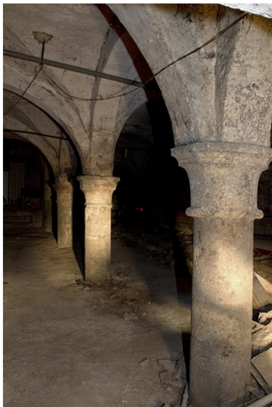
Logis principal : détail d'une rangée de colonnes de la cave.
