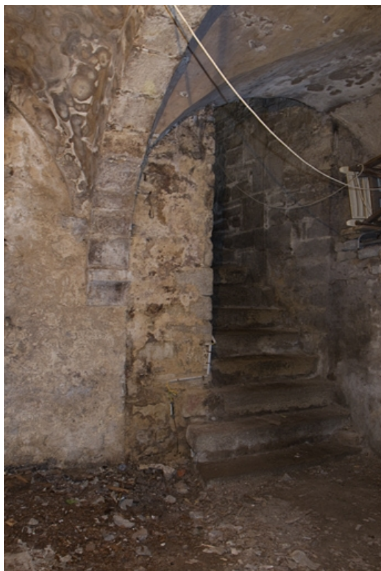
Logis principal : détail de l'escalier de la cave.
