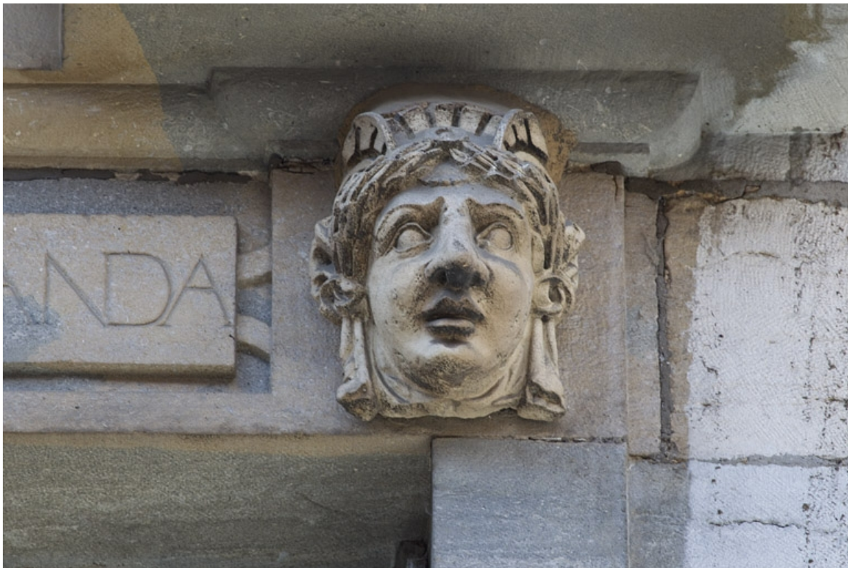
Façade antérieure, partie droite, cinquième fenêtre de l'étage à partir de la droite : détail du mascarone droit. 25, Besançon, 2, 4 rue des Granges, lieudit : îlot Bouteiller
