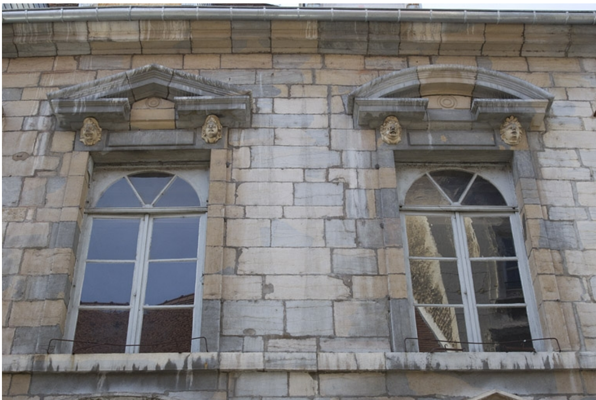
Façade antérieure, partie droite, premier étage : vue d'ensemble des première et deuxième fenêtres à partir de la droite. 25, Besançon, 2, 4 rue des Granges, lieudit : îlot Bouteiller
