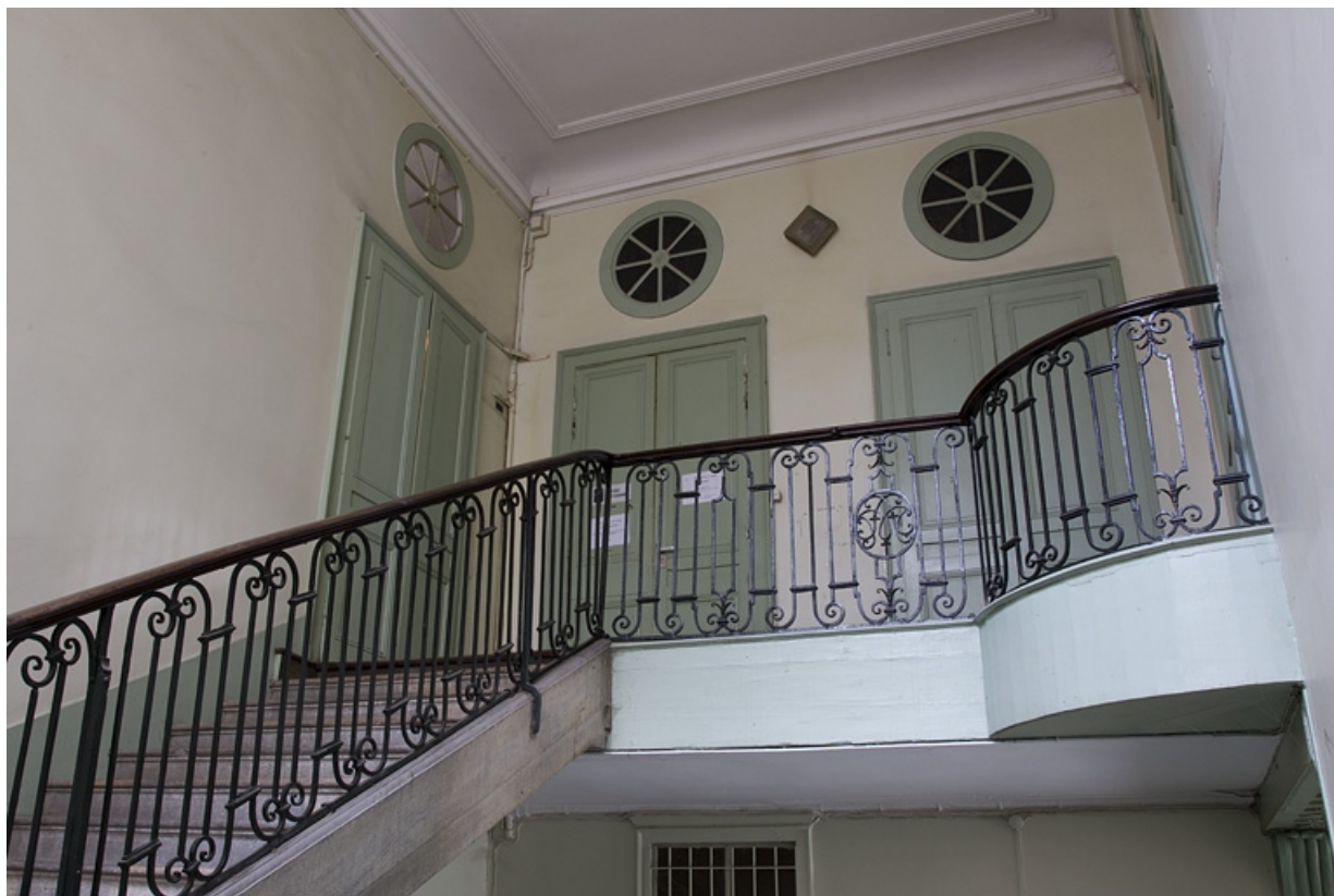
Intérieur, escalier d'honneur : détail de la partie supérieure.
