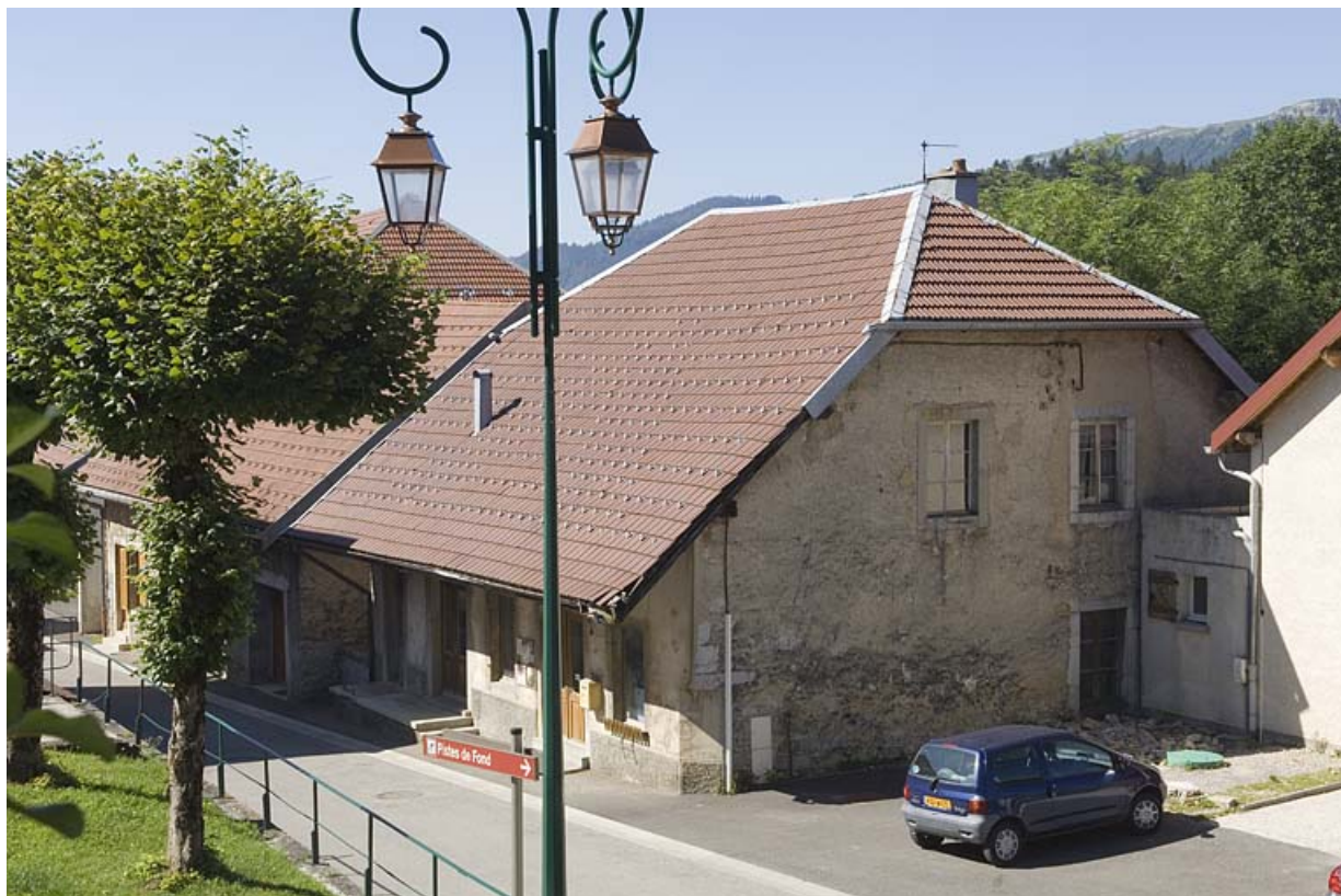
Façade antérieure et façade latérale droite.
