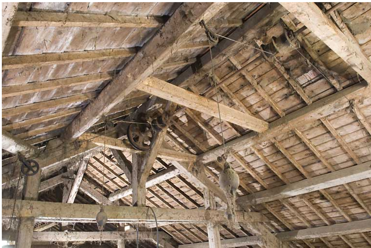
Grange haute : poulies et contrepois de la déchargeuse dans la charpente. 25, Jougne, 2 chemin de la Tirerie, lieudit : la Ferrière
