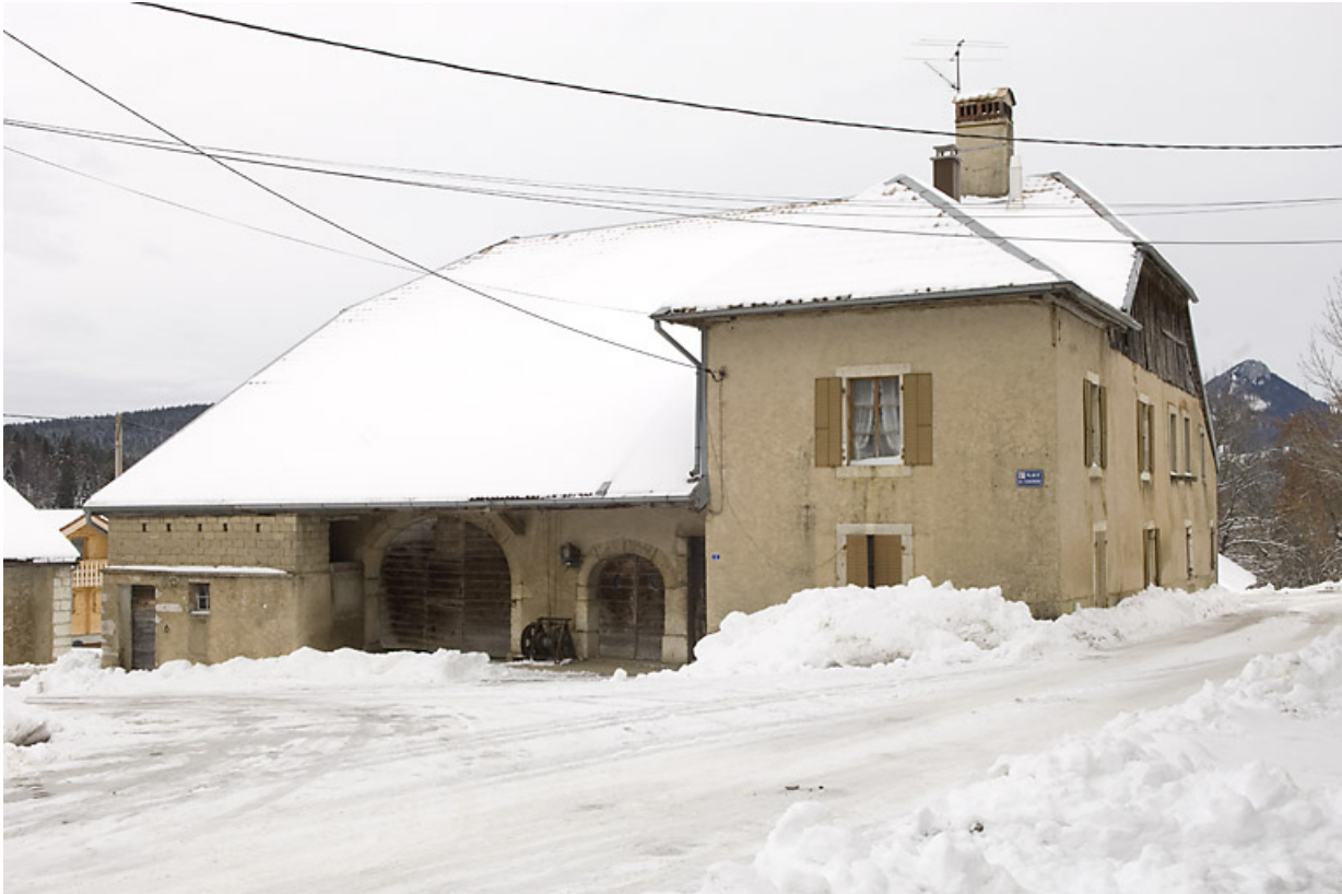
Ferme au 1 place des Cloutiers (Entre-les-Fourgs). 25, Jougne
