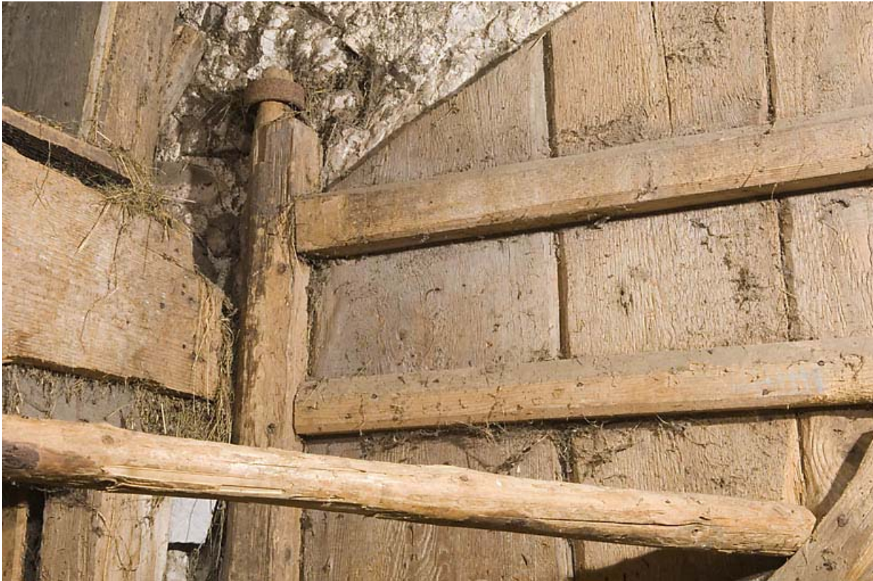
Façade antérieure, porte de grange : fixation de l'axe vertical du vantaill de droite (collier en partie haute). 25, Jougne, 1 place des Cloutiers, lieudit : Entre-les-Fourgs
