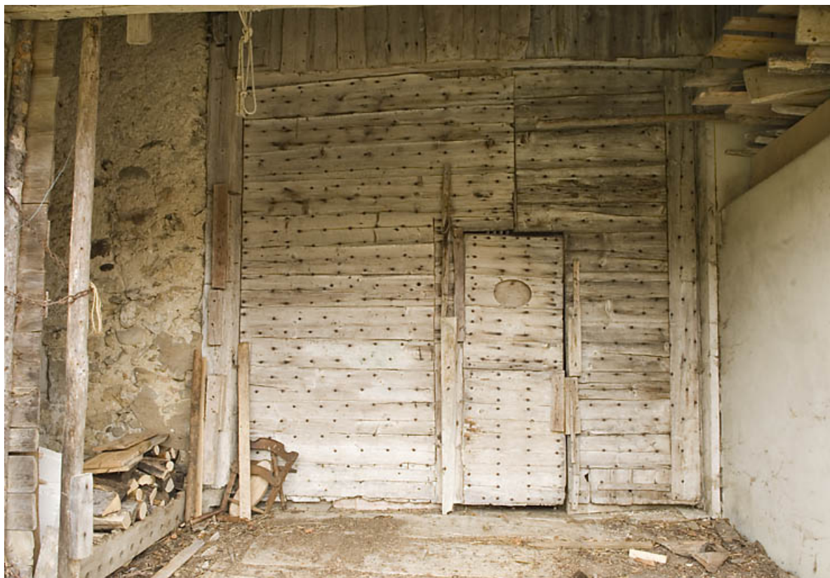
Façade postérieure : porte de la grange.
