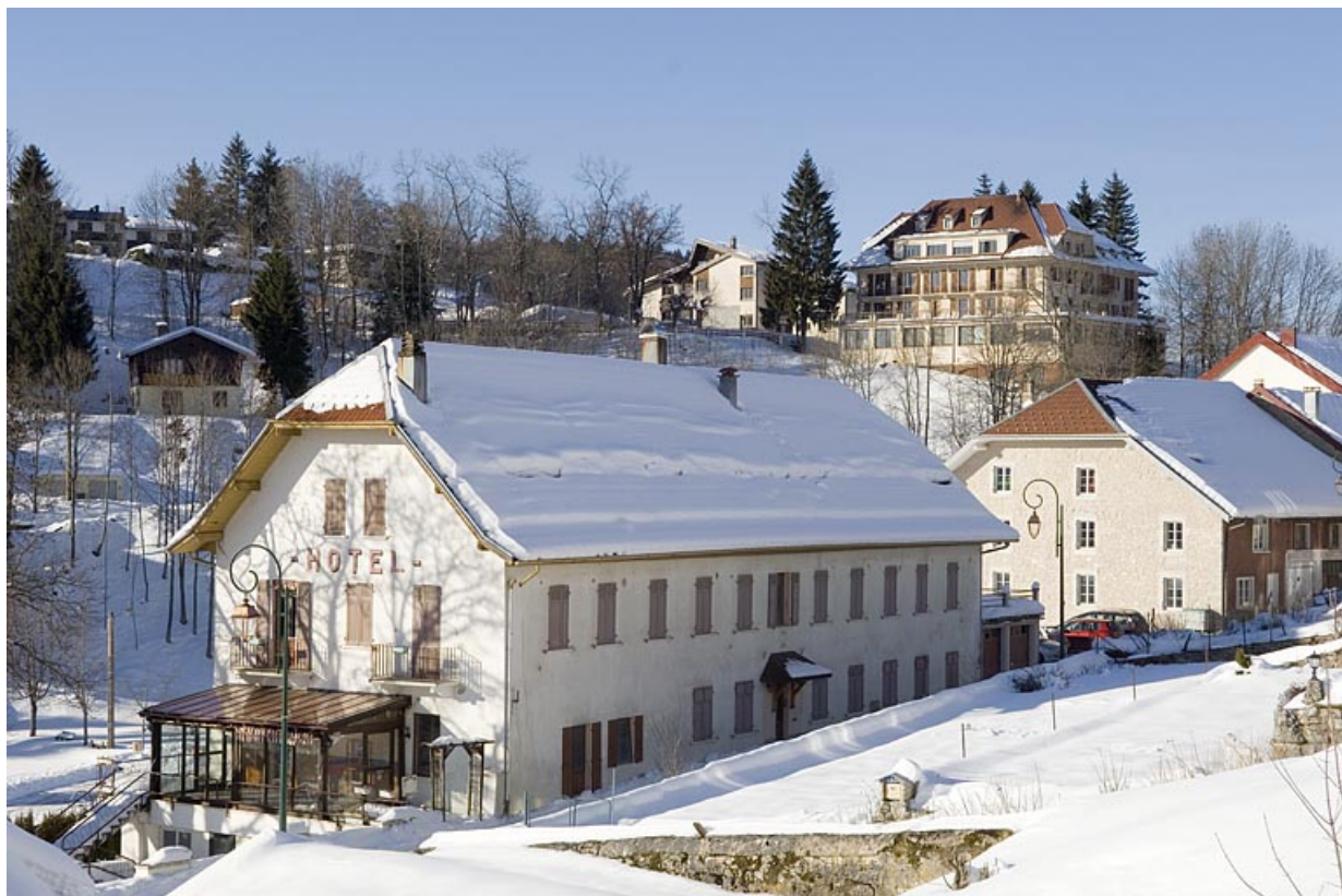
Façades antérieure et latérale gauche.
