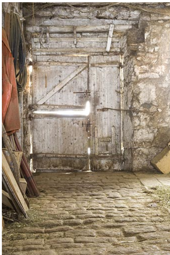
Etable : la porte vue de l'intérieur.
