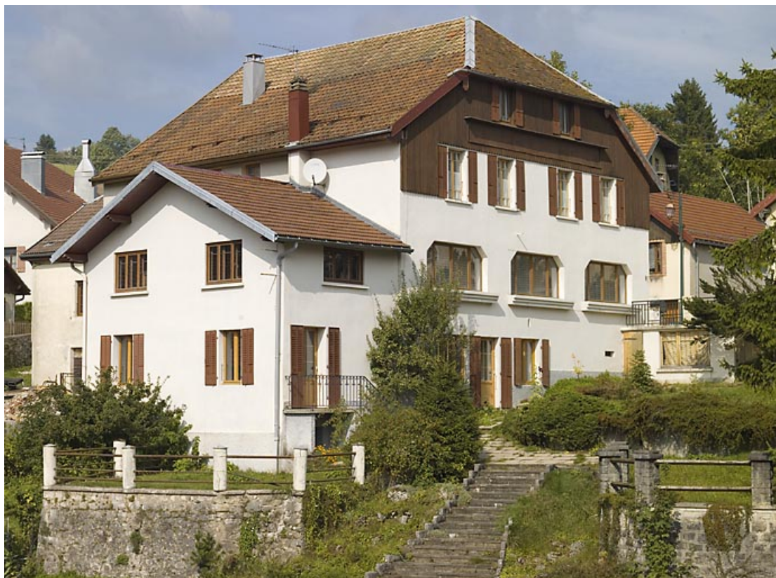
Façade postérieure et façade latérale gauche.
