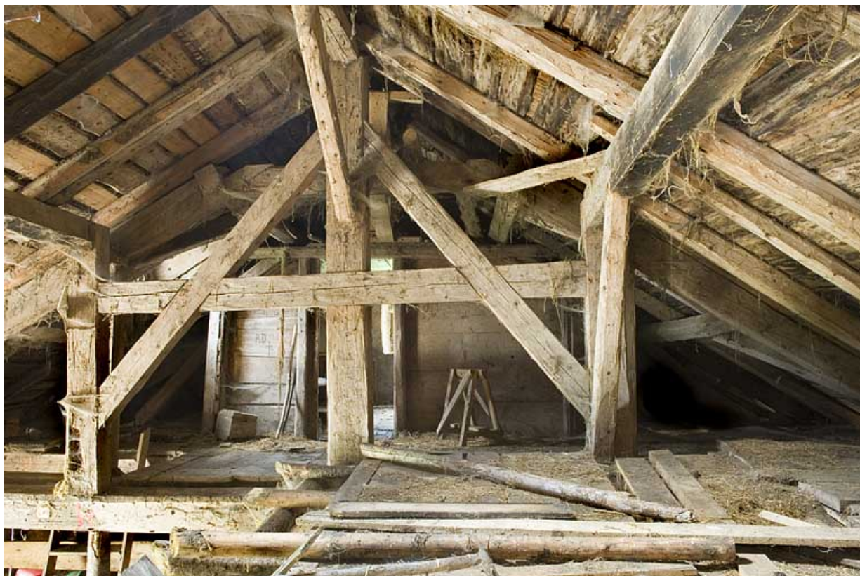
Vue générale de la charpente et, au fond, la porte ouvrant sur la chambre du berger. 25, Jougne, lieudit : la Bécasse
