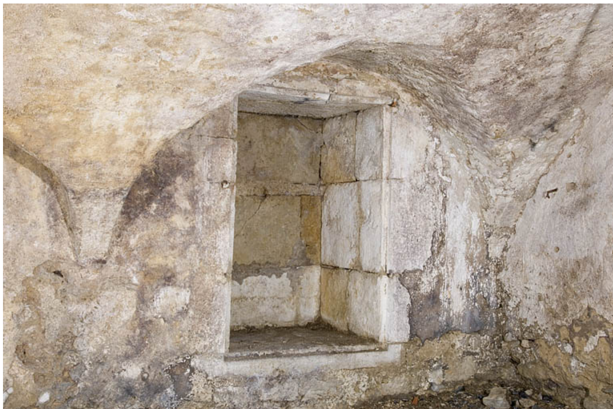
Sous-sol : détail, niche.
