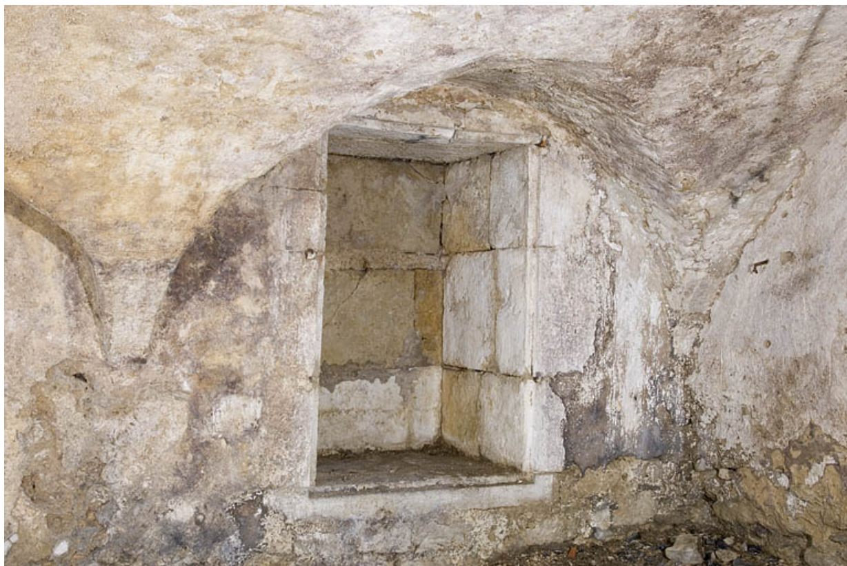
Sous-sol : détail, niche.
