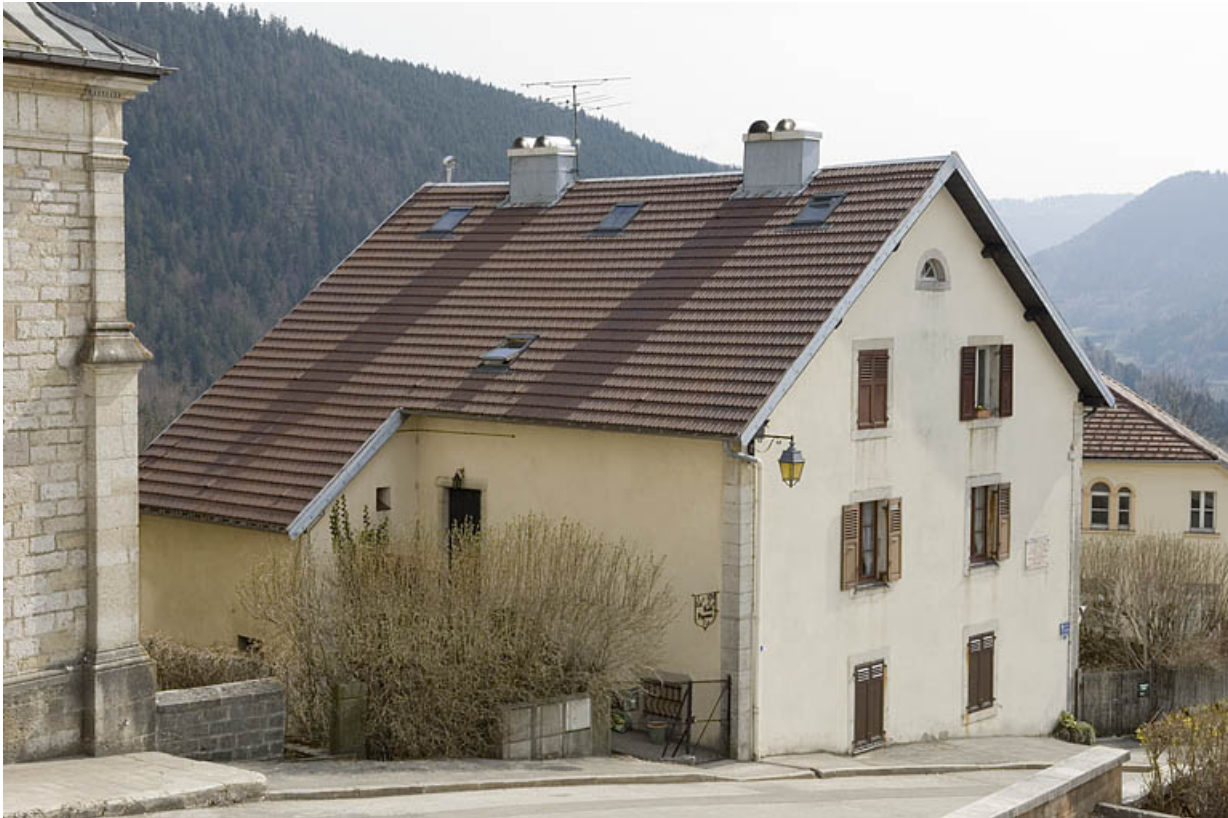
Façade antérieure et élévation droite.
