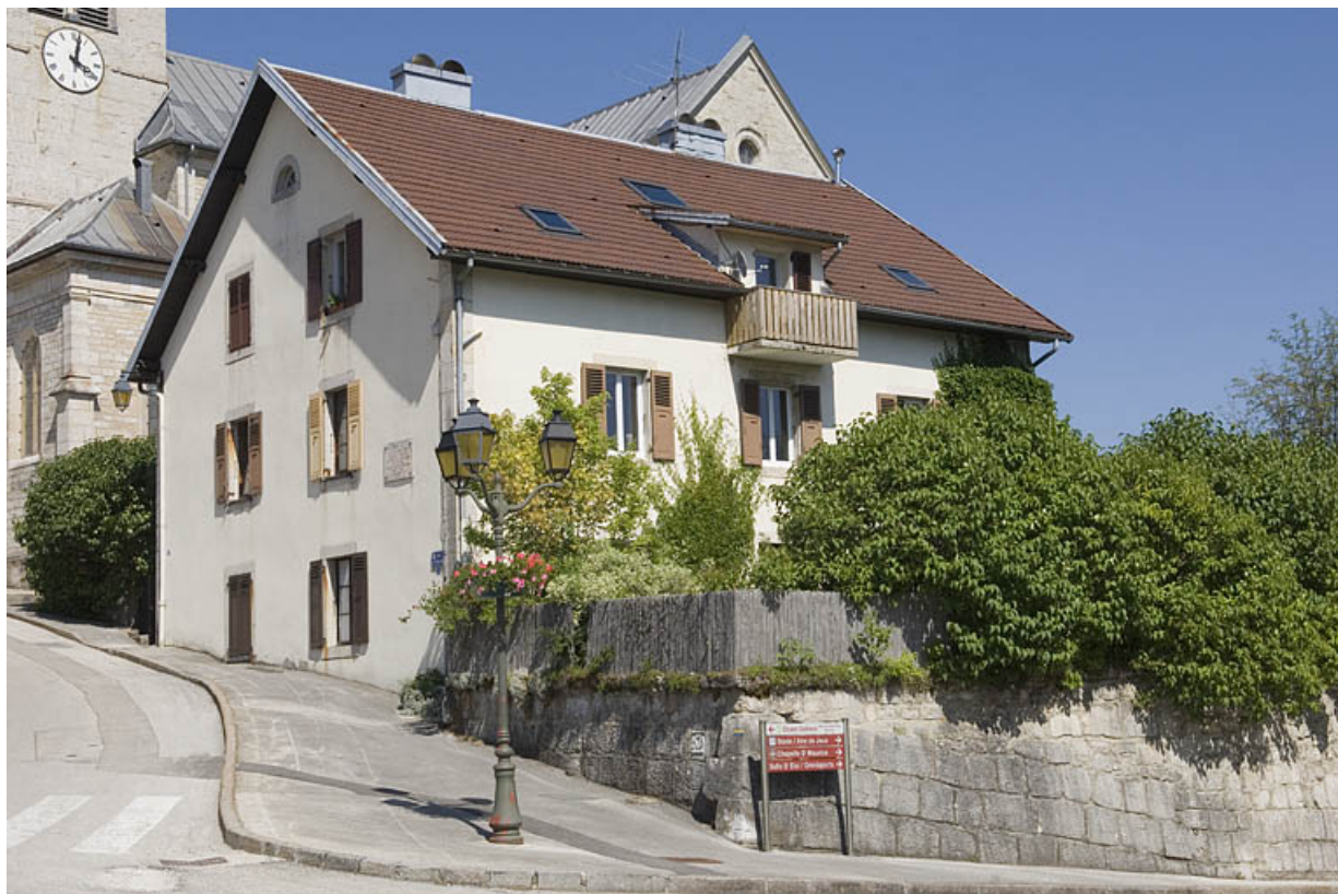
Façade postérieure et élévation droite.
