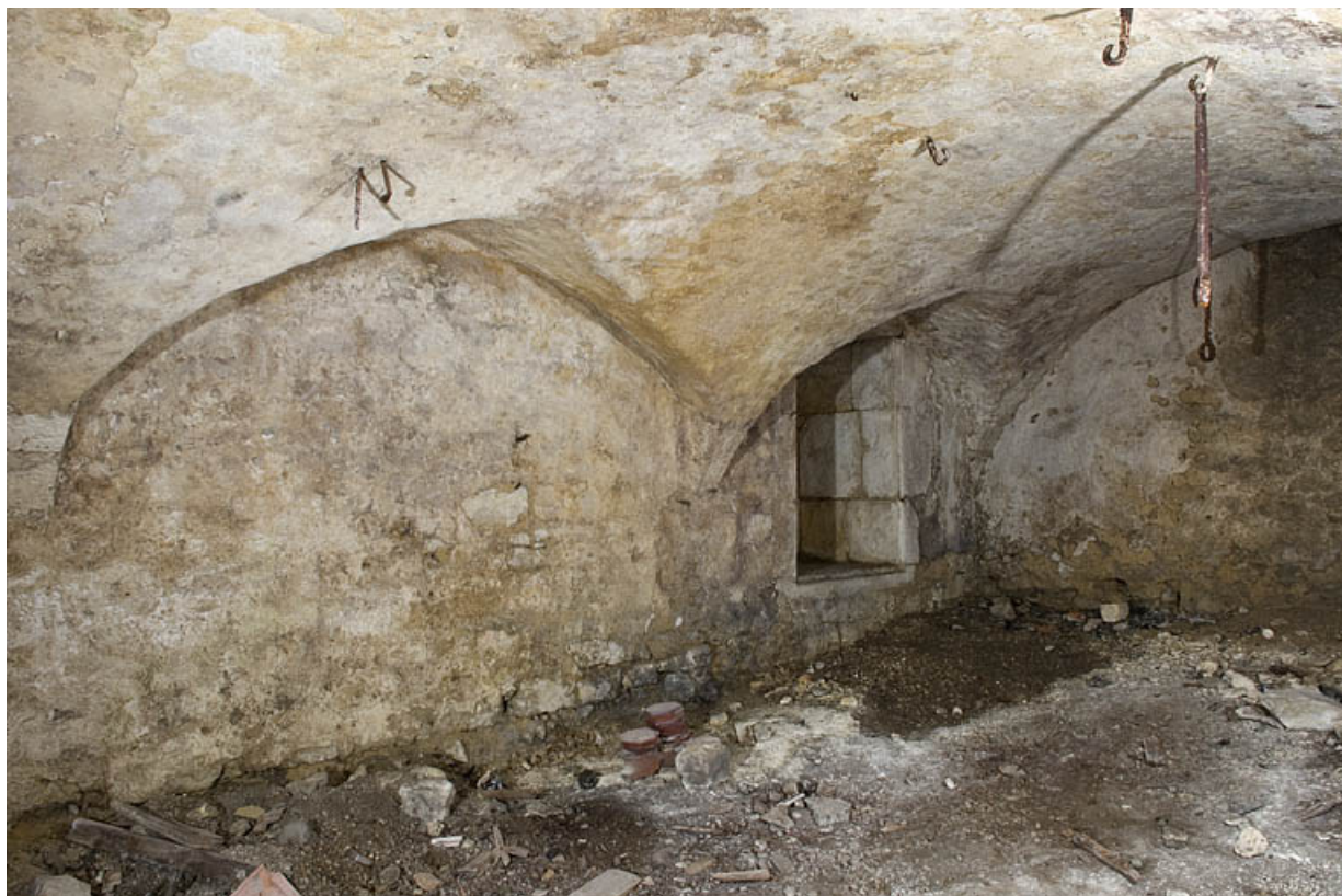
Sous-sol, vue de trois quart gauche.
