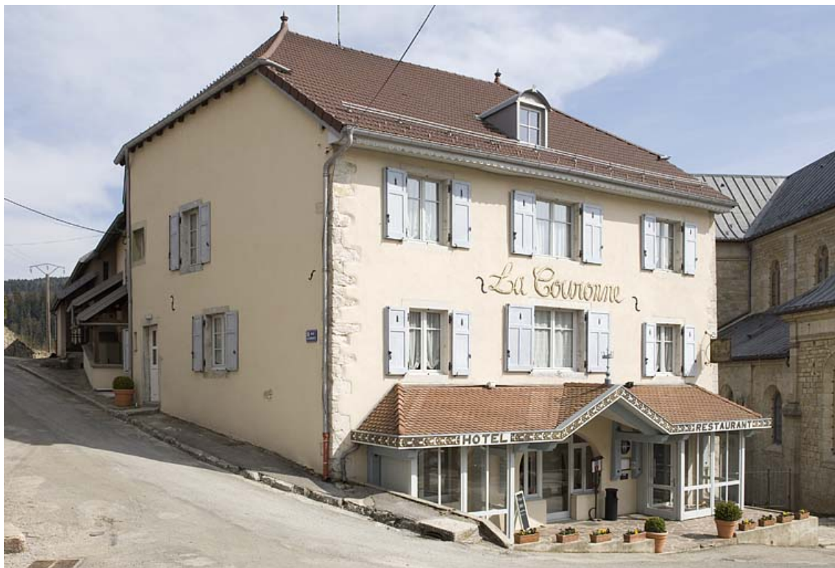
Façade antérieure et façade latérale gauche. 25, Jougne, 6 rue de l' Église
