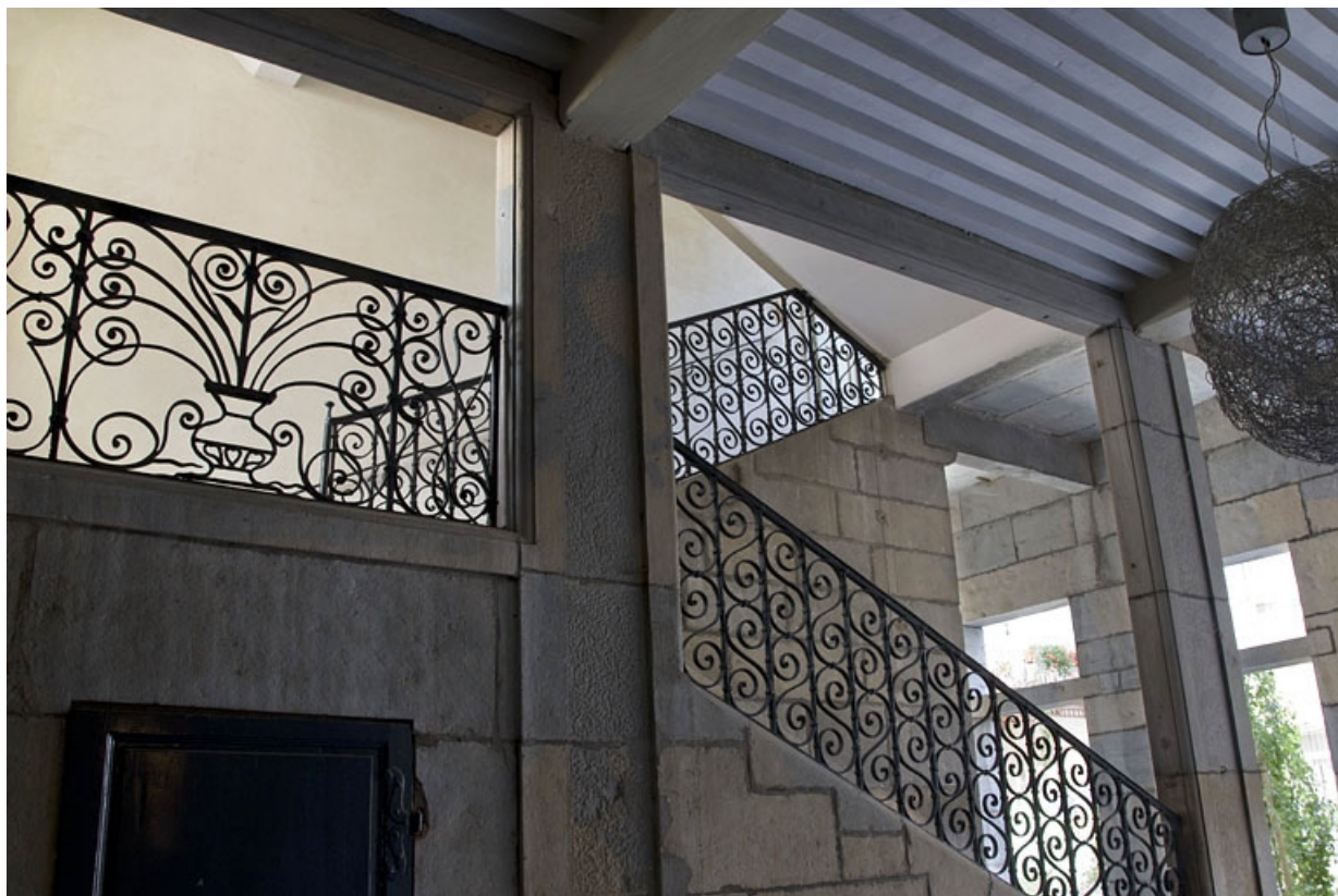
Logis principal, intérieur, escalier : détail des premières volées depuis le passage cocher. 25, Besançon, 11 rue Pasteur, lieudit : îlot Sainte-Ursule
