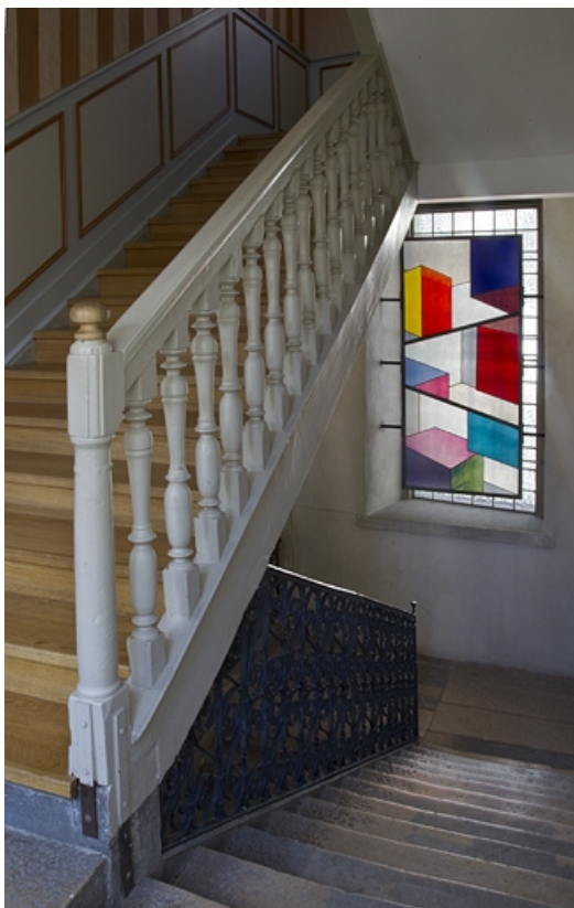
Logis principal, intérieur : détail de la partie supérieure de l'escalier avec une rampe en bois tourné. 25, Besançon, 11 rue Pasteur, lieudit : îlot Sainte-Ursule
