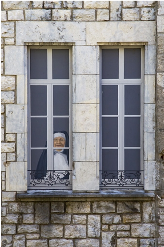
Logis principal, extrémité de l'aile droite, façade sur cour : détail des fenêtres du premier étage. 25, Besançon, 11 rue Pasteur, lieudit : îlot Sainte-Ursule
