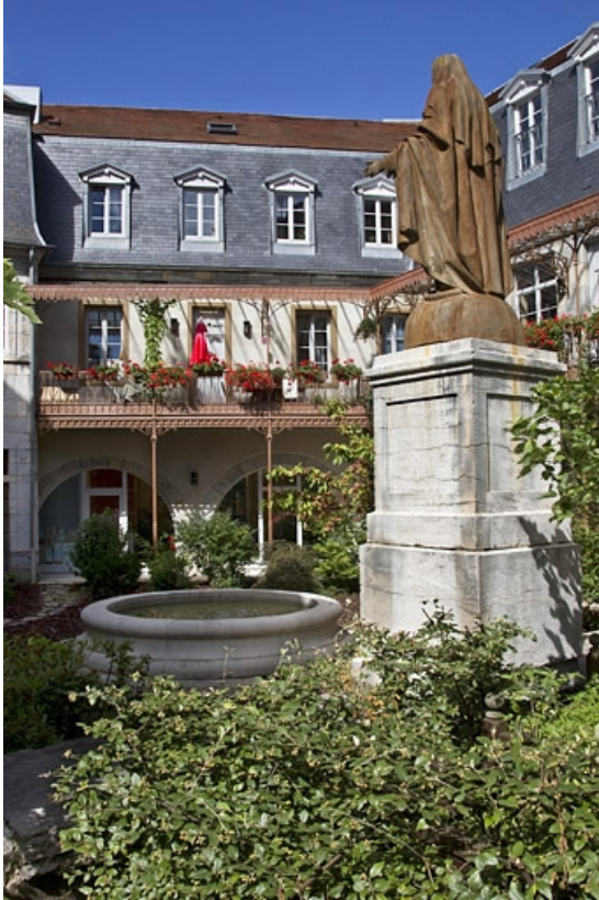
Logis principal, vue d'ensemble de la façade postérieure depuis le fond de la cour. 25, Besançon, 11 rue Pasteur, lieudit : îlot Sainte-Ursule
