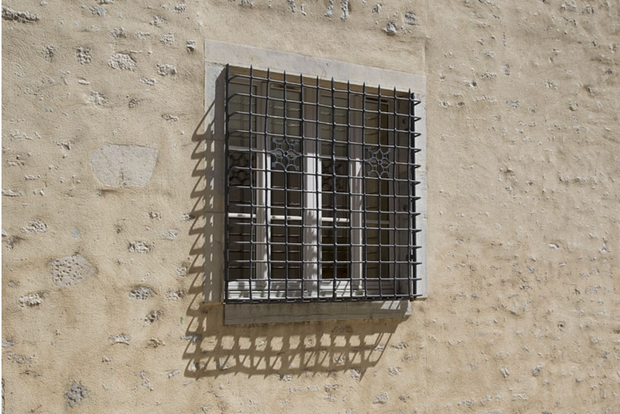
Logis principal, façade antérieure : détail d'une grille de fenêtre.
