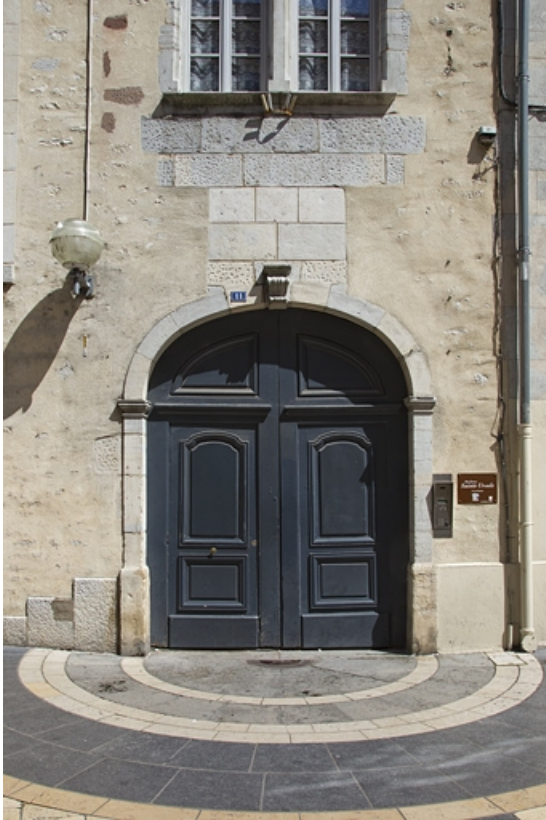
Logis principal, façade antérieure : détail du portail d'entrée.
