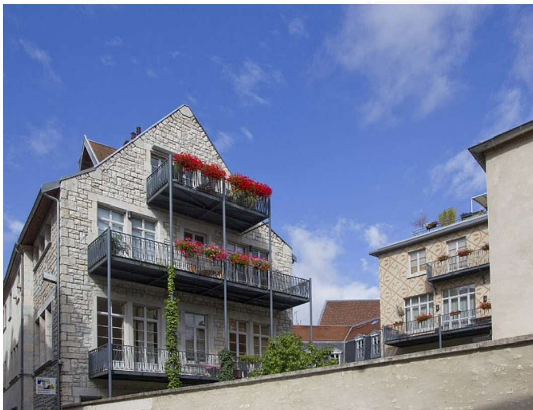
Logis principal, pignon de l'aile droite : vue d'ensemble depuis la rue d'Anvers.
