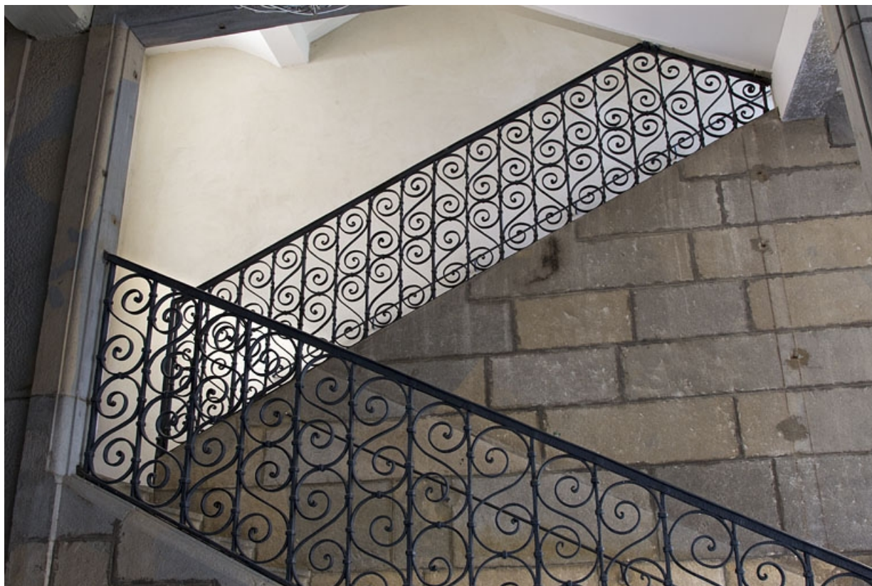
Logis principal, intérieur, escalier : détail de la rampe en ferronnerie. 25, Besançon, 11 rue Pasteur, lieudit : îlot Sainte-Ursule
