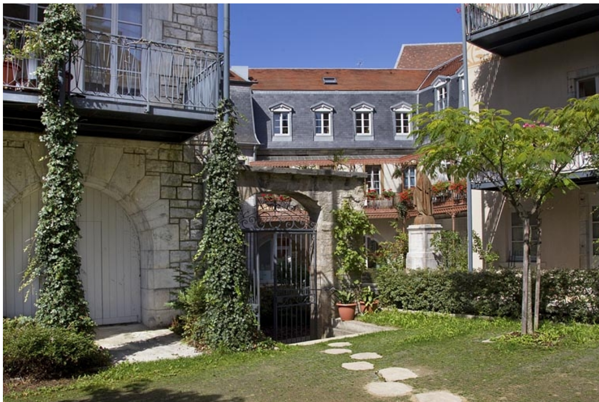
Détail de la porte séparant la cour de l'ancien jardin. 25, Besançon, 11 rue Pasteur, lieudit : îlot Sainte-Ursule
