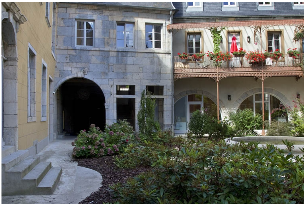
Logis principal, façade postérieure : détail du passage cocher depuis le fond de la cour. 25, Besançon, 11 rue Pasteur, lieudit : îlot Sainte-Ursule
