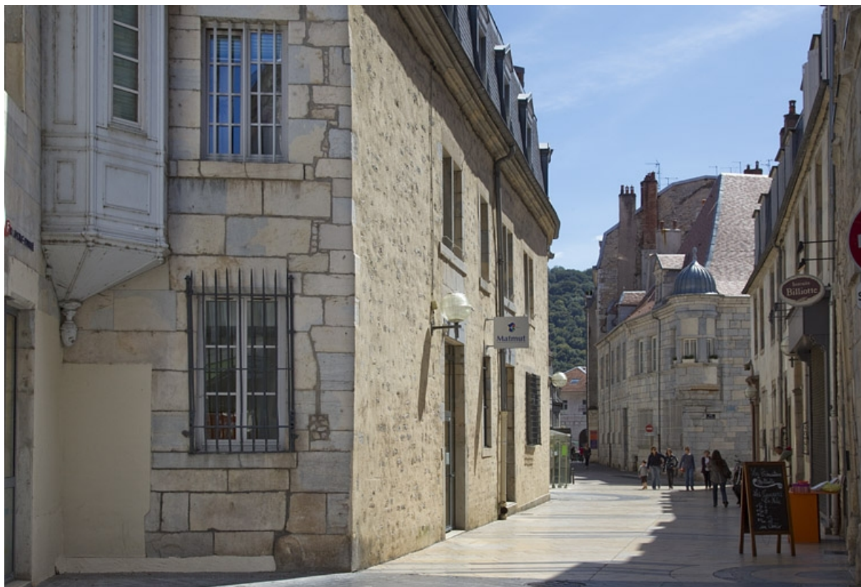
Logis principal, façade antérieure, partie gauche : de trois quarts gauche. 25, Besançon, 11 rue Pasteur, lieudit : îlot Sainte-Ursule
