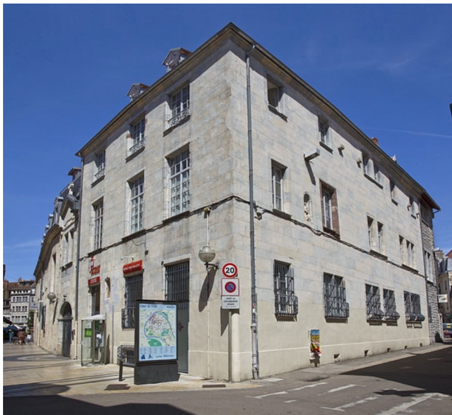
Logis principal : vue d'ensemble depuis l'angle des deux rues.
