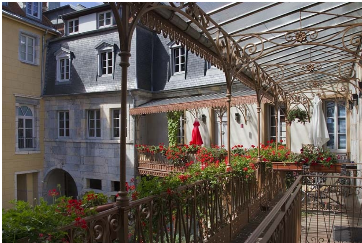
Logis principal : vue de l'intérieur du auvent métallique.
