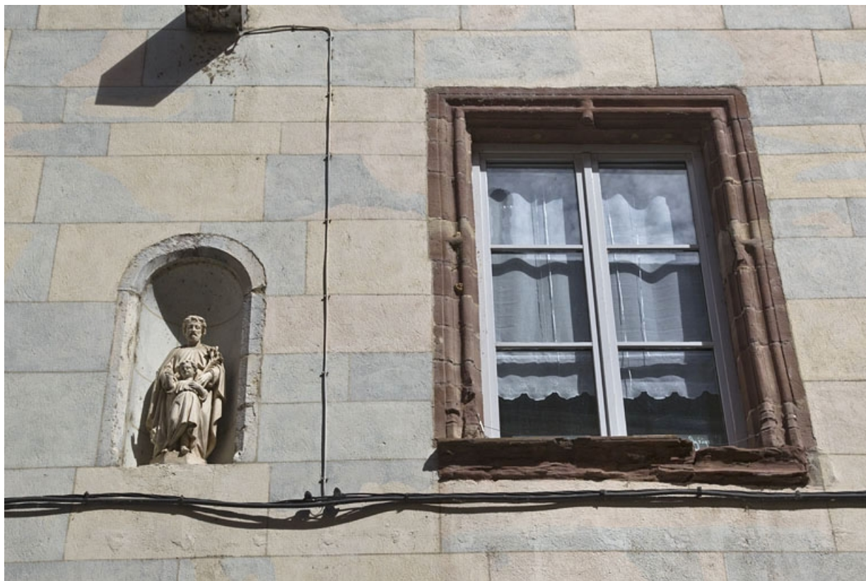
Logis principal, aile droite, façade postérieure : détail d'une niche et d'une fenêtre du premier étage. 25, Besançon, 11 rue Pasteur, lieudit : îlot Sainte-Ursule
