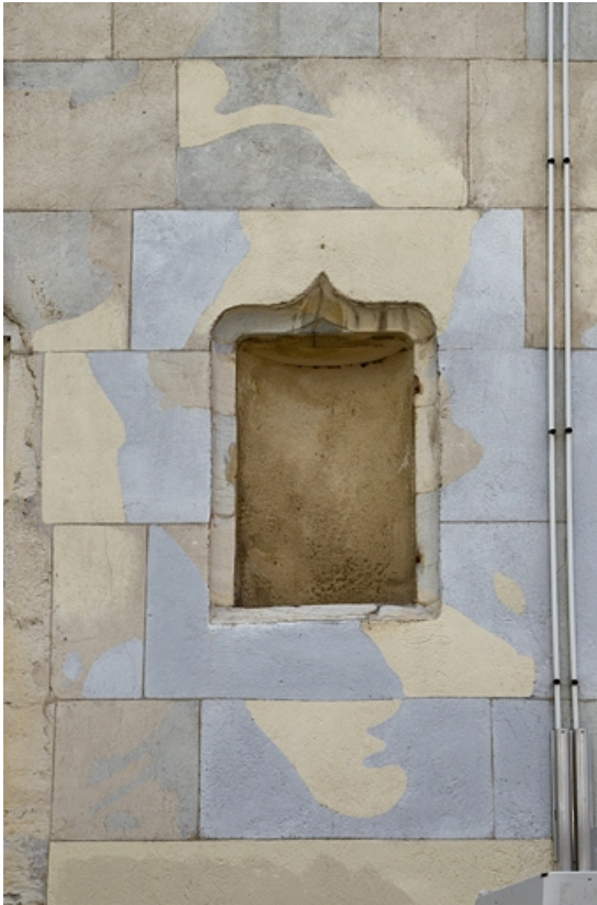
Logis principal, façade antérieure, partie droite : détail d'une niche. 25, Besançon, 11 rue Pasteur, lieudit : îlot Sainte-Ursule
