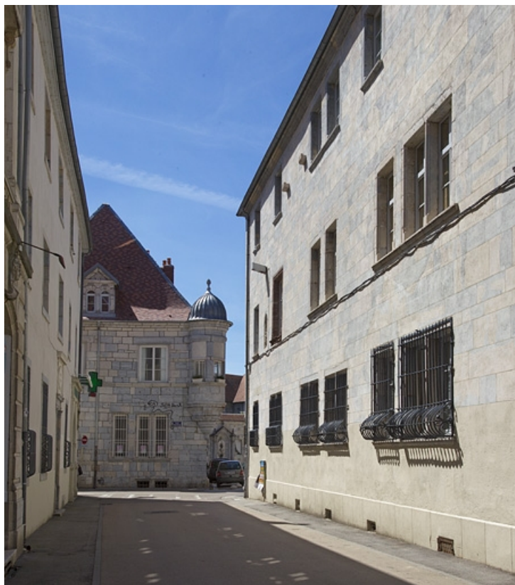
Logis principal, façade latérale droite sur rue : de trois quarts droit. 25, Besançon, 11 rue Pasteur, lieudit : îlot Sainte-Ursule
