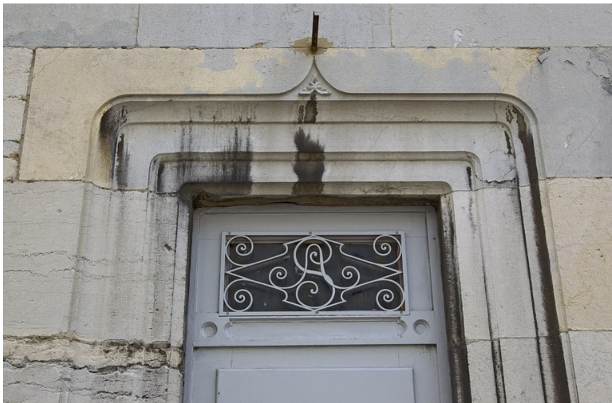
Logis principal, façade sur rue : détail de la partie supérieure de la porte. 25, Besançon, 7 rue d' Anvers, lieudit : îlot d' Emskerque
