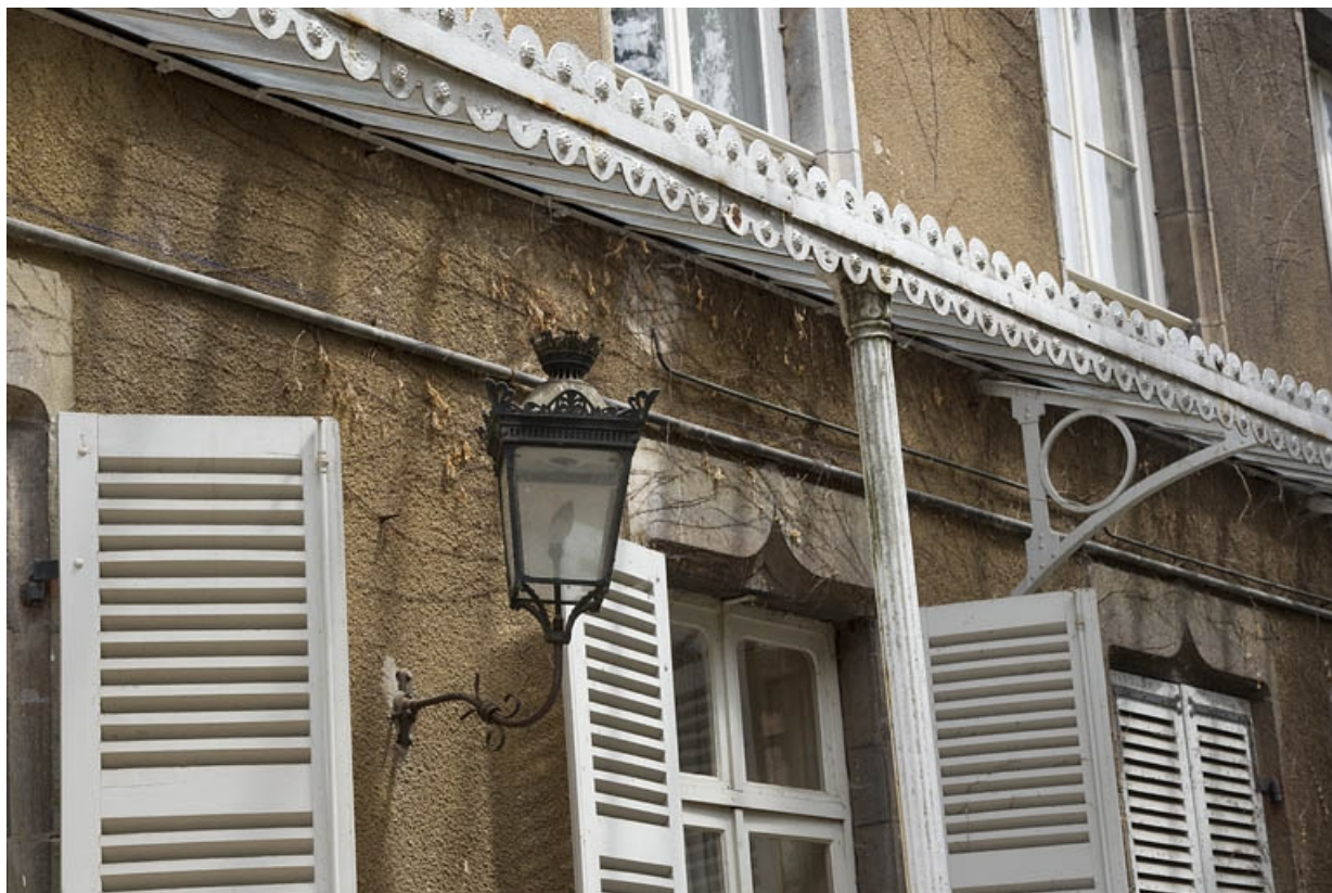
Logis principal, façade antérieure : détail du bec de gaz.
