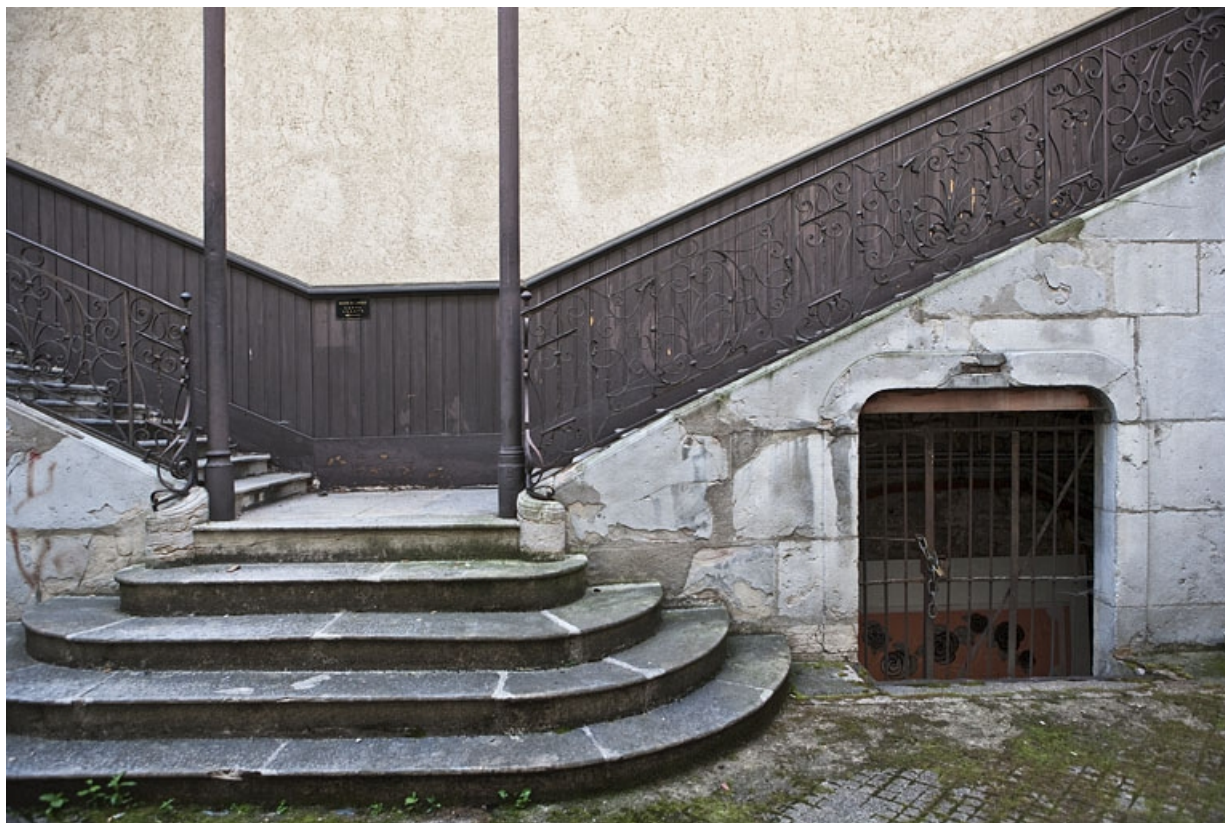
Escalier à cage ouverte sur cour : détail de l'embranchement de l'escalier.
