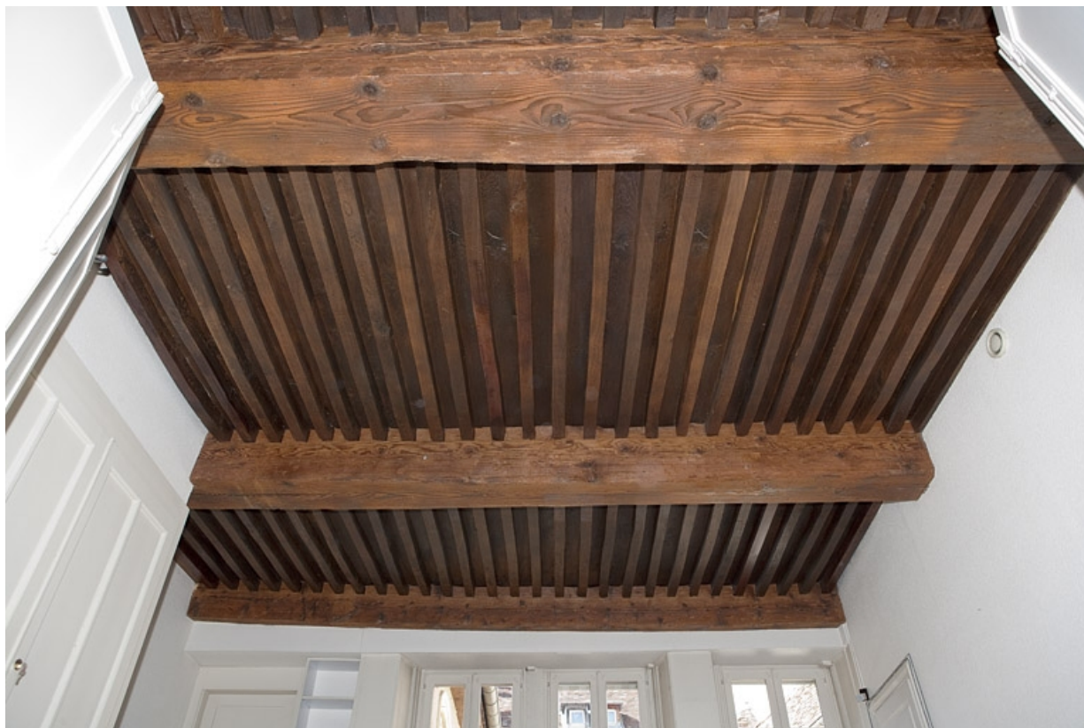
Logis principal, appartement du premier étage : détail du plafond à la française.
