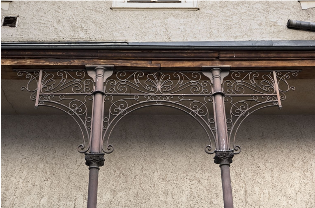
Escalier à cage ouverte sur cour : détail des arcs et des piliers en métal soutenant la galerie, partie centrale.
