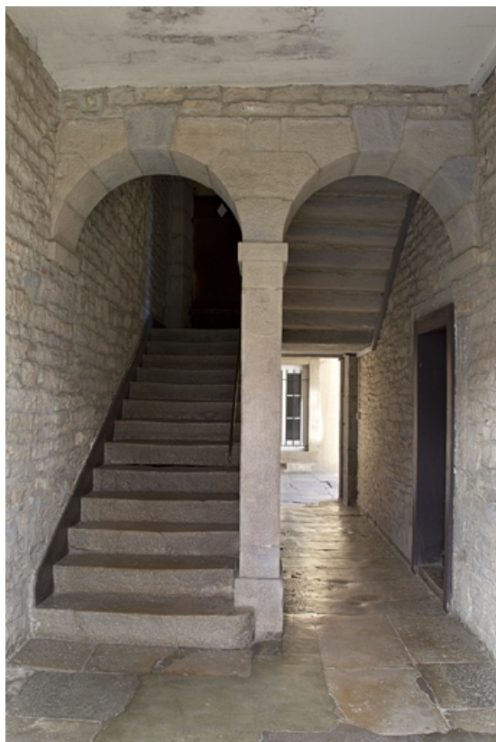
Logis principal : vue d'ensemble de l'escalier dans oeuvre.
