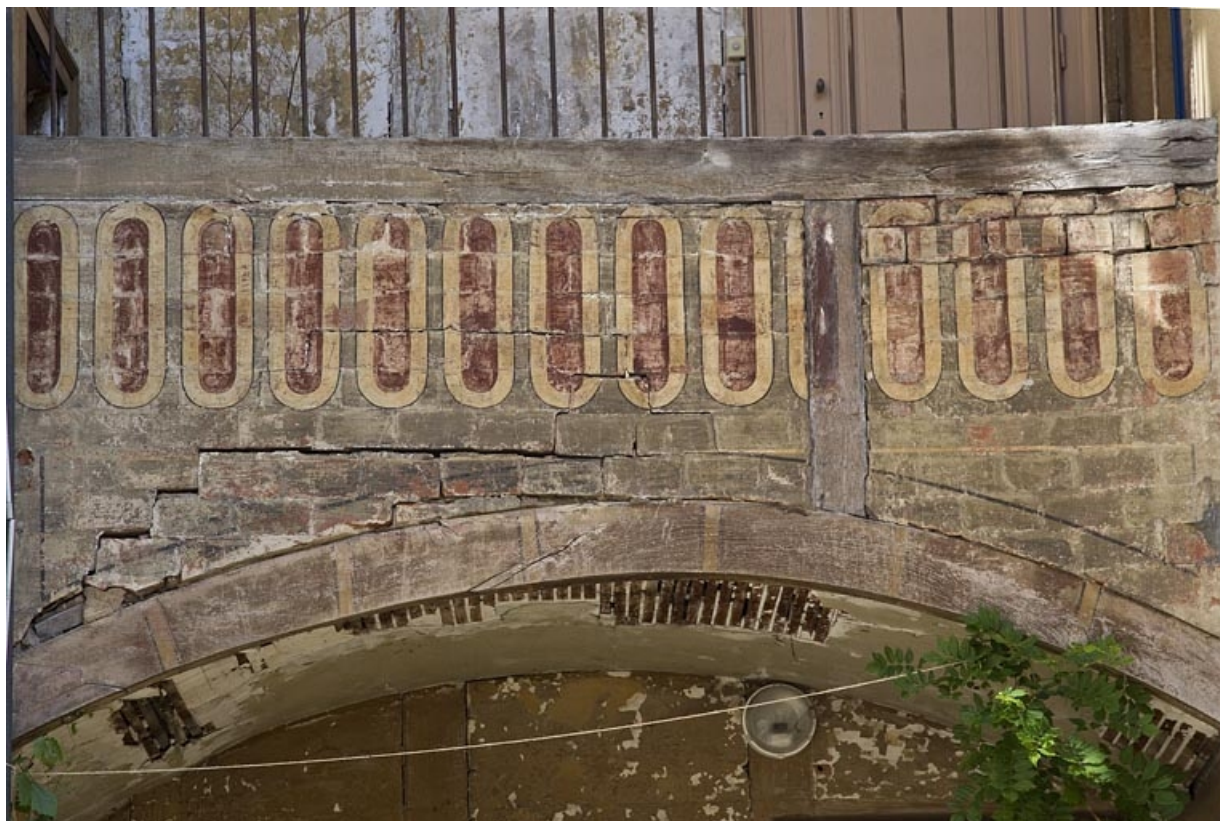
Galleries superposées entre le logis secondaire gauche et le logis principal : détail d'un décor peint.
