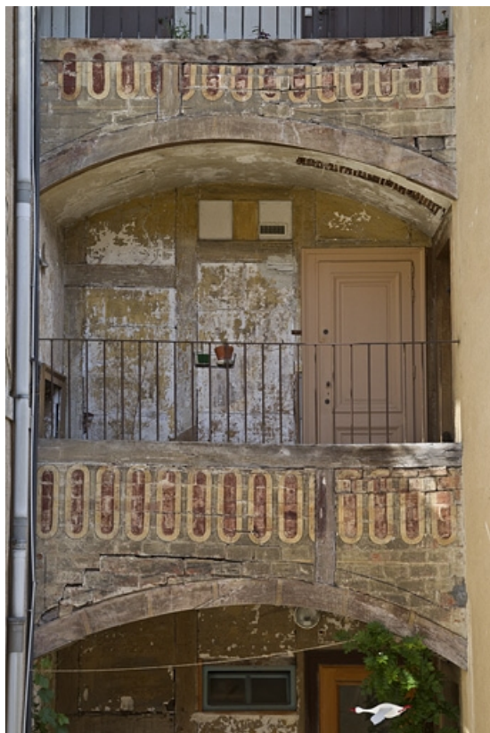
Galleries superposées entre le logis secondaire gauche et le logis principal : détail de la galerie du deuxième étage. 25, Besançon, 15 rue Pasteur, lieudit : îlot d' Emskerque
