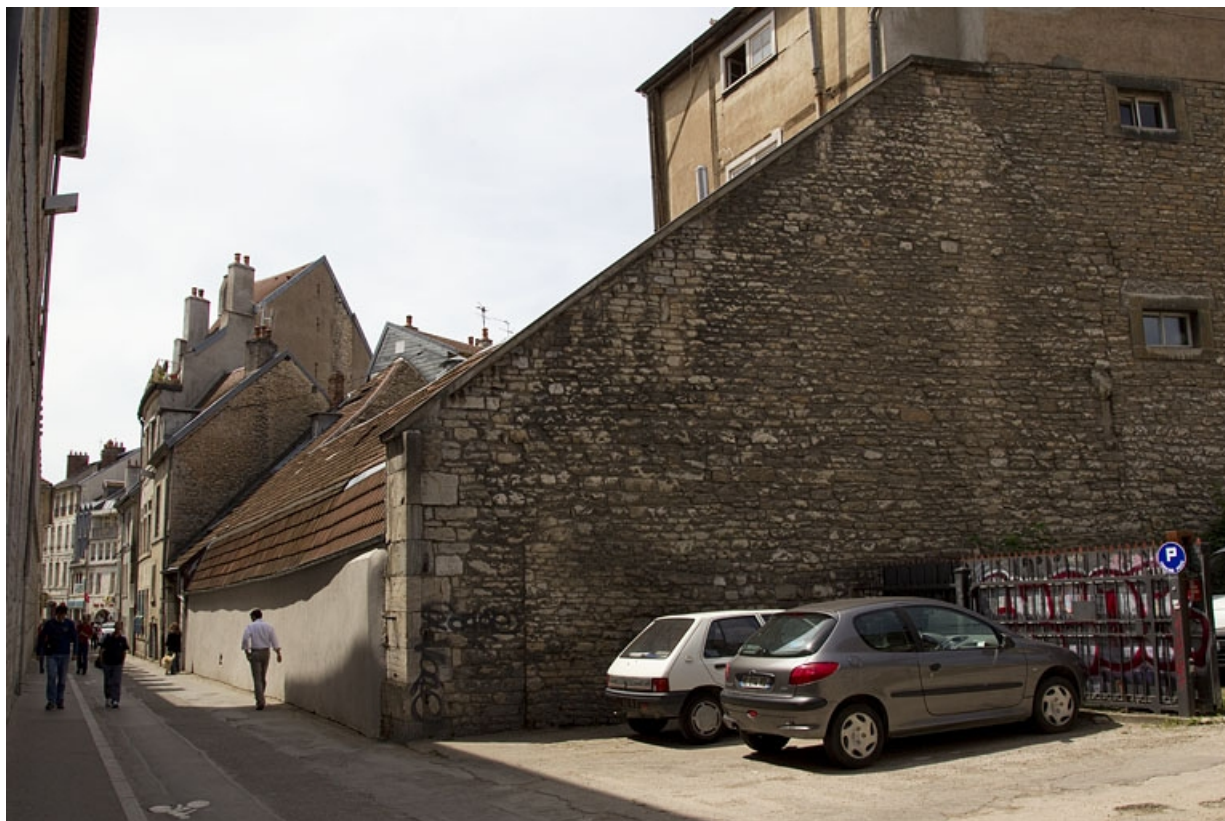
Logis secondaire au fond de la cour : façade postérieure, de trois quarts droit. 25, Besançon, 15 rue Pasteur, lieudit : îlot d' Emskerque
