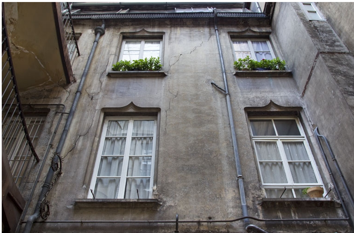
Logis principal, aile en fond de cour : vue d'ensemble. 25, Besançon, 1, 3 rue d' Anvers, lieudit : îlot d' Emskerque
