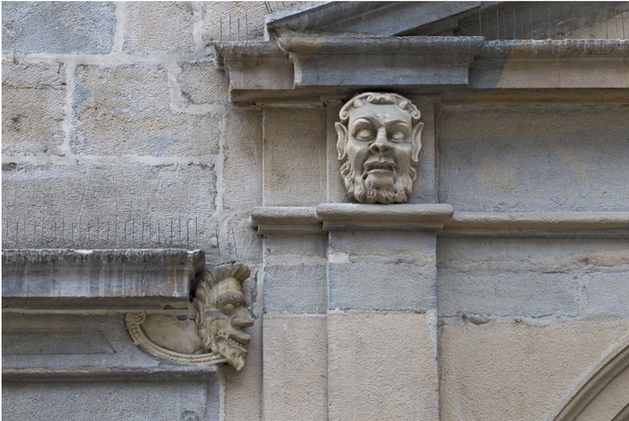
Logis principal, façade sur rue, partie droite, rez-de-chaussée, baie à droite de l'arcade boutiquière : mascarón droit et mascarón gauche ornant le portail.
