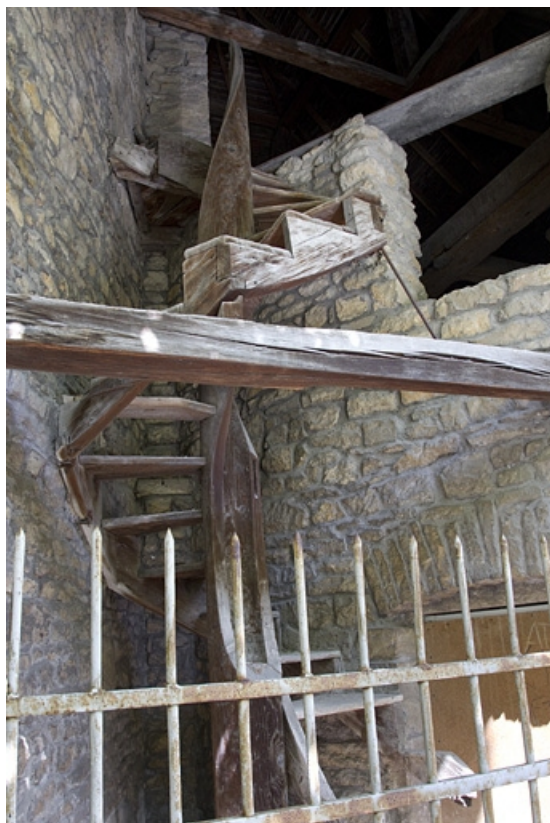
Fabrique de jardin : détail de l'escalier, vue d'ensemble.
