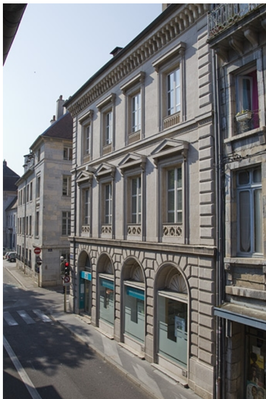
Logis principal : vue d'ensemble de la façade latérale droite.
