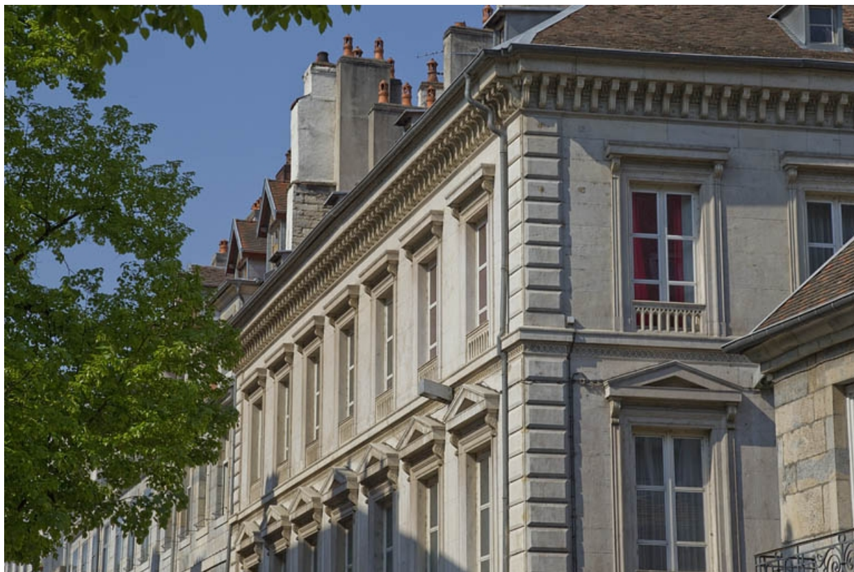
Logis principal : détail des fenêtres du deuxième étage sur la rue de la Préfecture.
