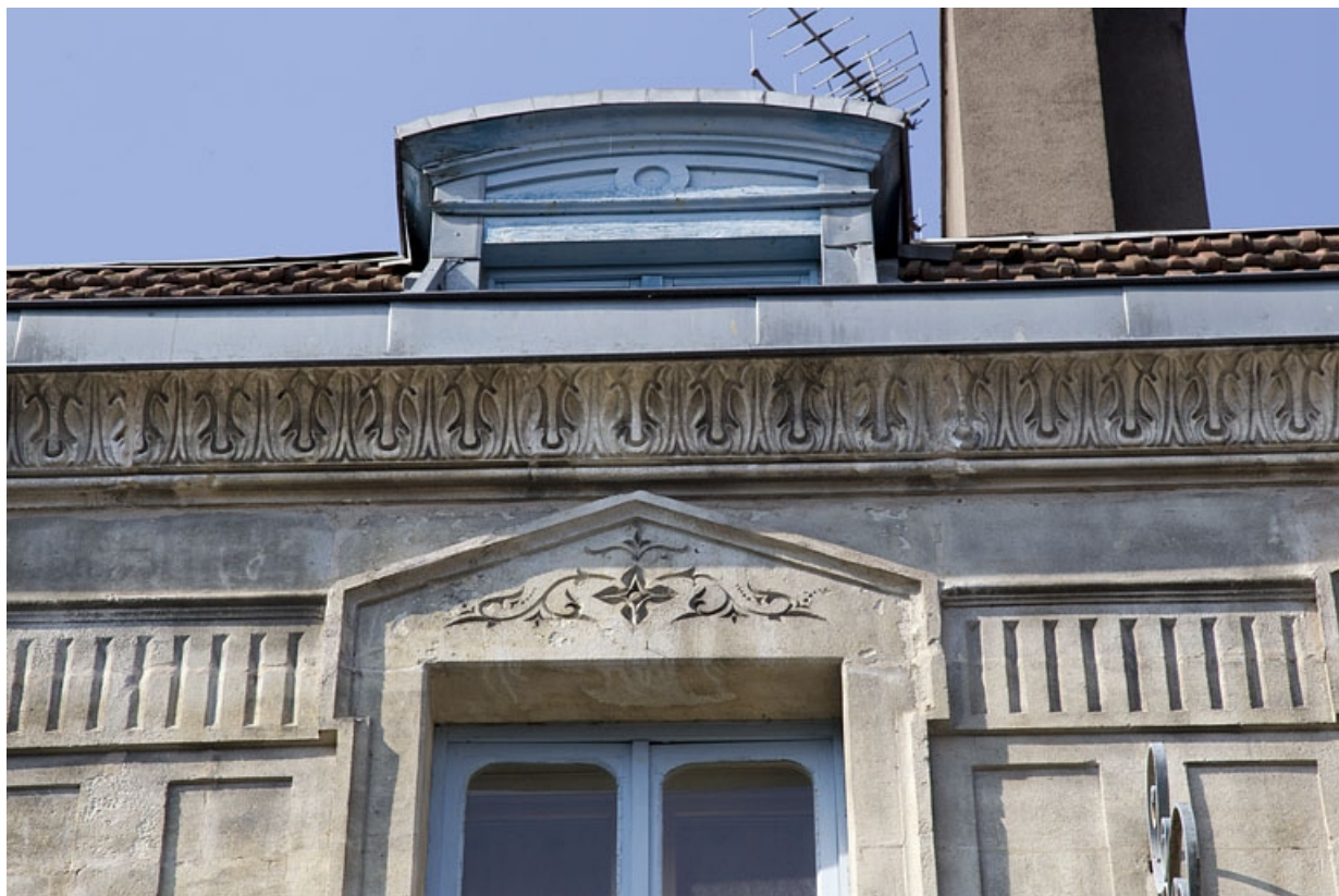
Logis principal, façade sur rue, troisième étage : détail du décor d'une baie et de la corniche du toit.
