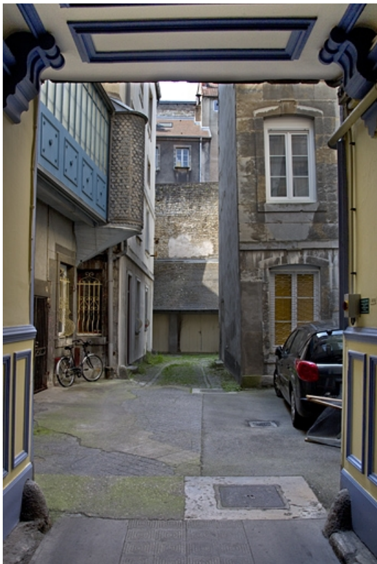
Vue d'ensemble de la première cour, depuis le passage cocher.
