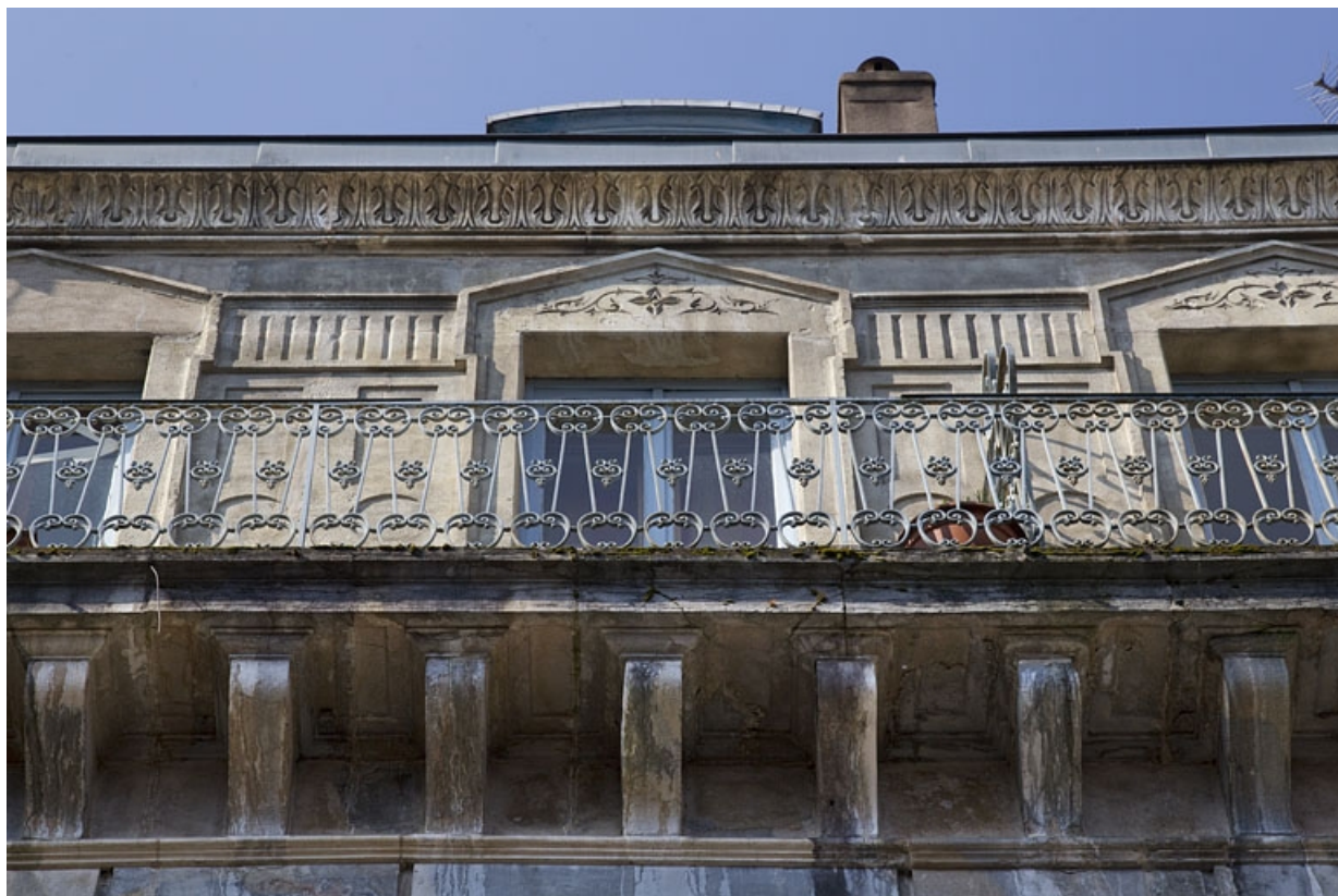
Logis principal, façade sur rue, troisième étage : détail du balcon filant en ferronnerie.
