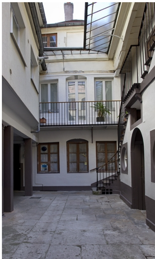
Logis principal, façade postérieure depuis le fond de la cour.
