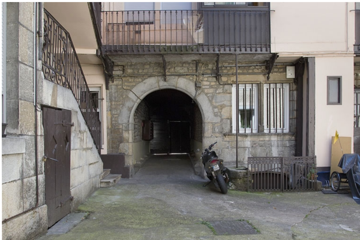
Logis principal, façade postérieure : détail du passage cocher.
