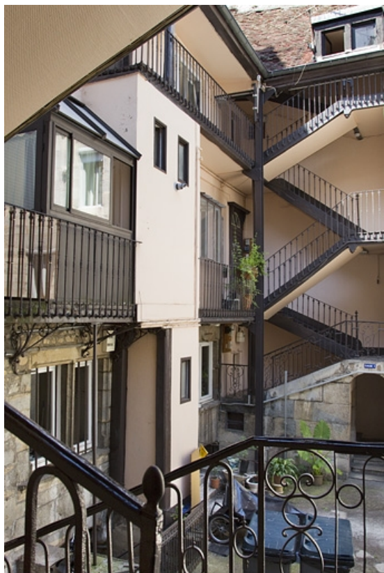
Vue d'ensemble de l'escalier à cage ouverte gauche, depuis l'escalier droit. 25, Besançon, 11 rue Rivotte, lieudit : îlot des Jacobins
