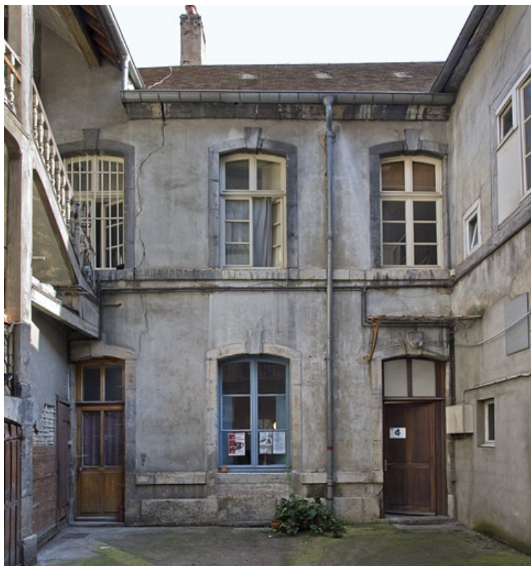
Logis secondaire : vue d'ensemble de la façade antérieure.
