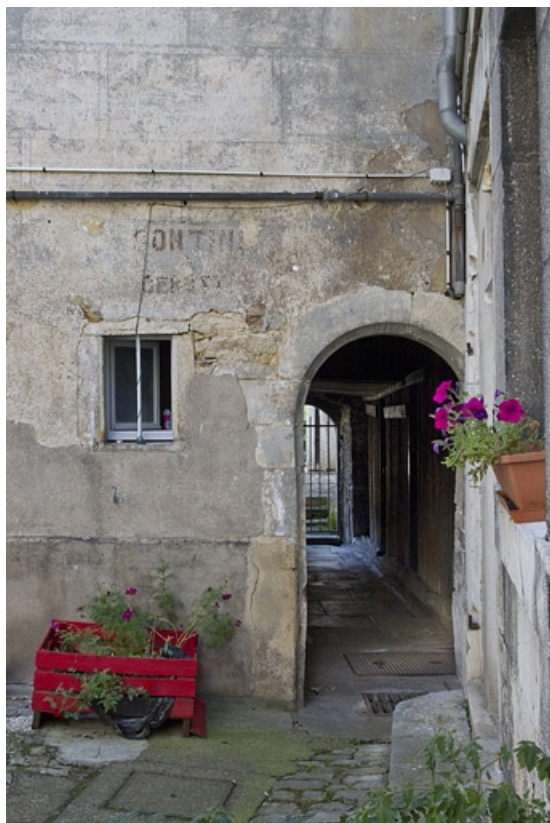
Premier logis secondaire : détail du couloir d'accès à la deuxième cour.
