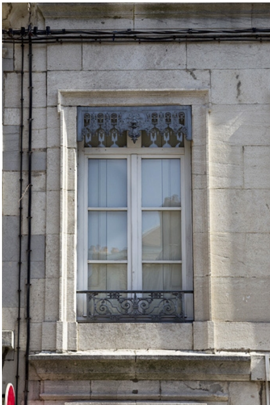
Logis principal, façade antérieure : détail d'une fenêtre du premier étage. 25, Besançon, 19 rue de Pontarlier, lieudit : îlot des Jacobins
