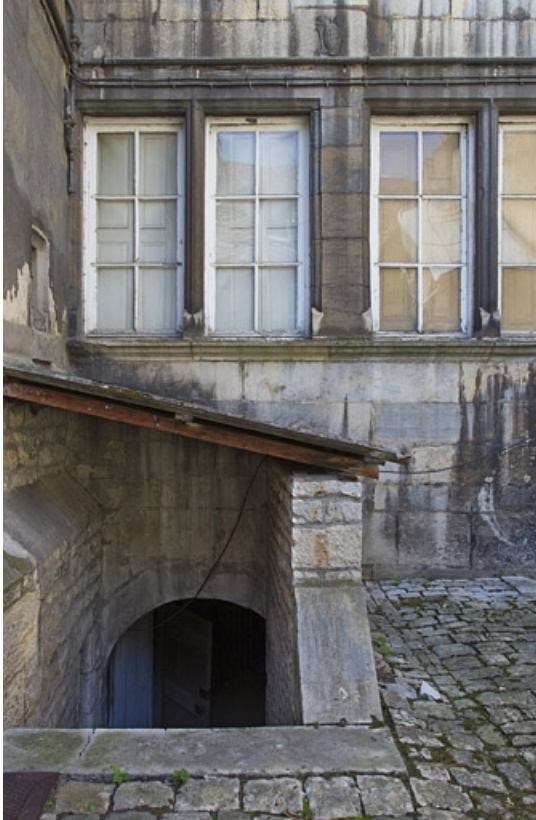
Logis principal, façade postérieure : détail de l'entrée de la cave.
