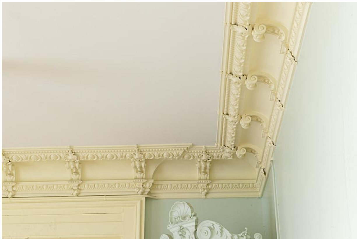
Logis au fond de la deuxième cour, pièce du rez-de-chaussée : détail de la voussure du plafond.
