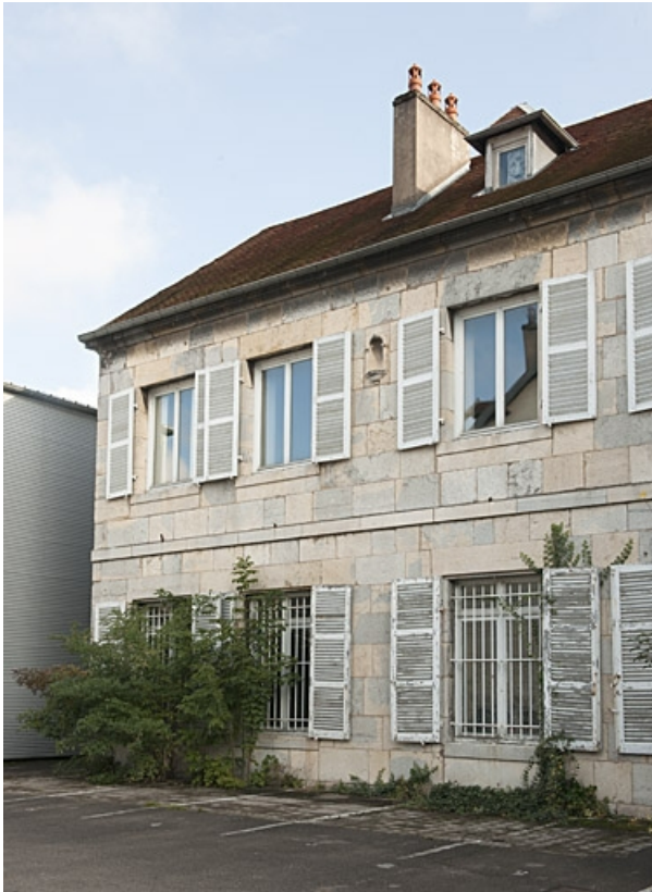
Logis au fond de la deuxième cour : partie gauche. 25, Besançon, 9 rue de Pontarlier, lieudit : îlot Sarrail
