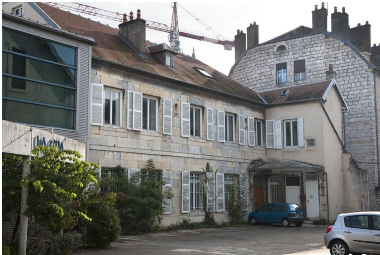
Logis au fond de la deuxième cour : vue d'ensemble de trois quarts gauche. 25, Besançon, 9 rue de Pontarlier, lieudit : îlot Sarrail
