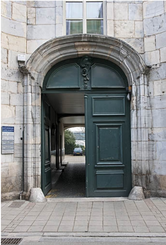
Façade antérieure de l'hôtel : détail du portail.
