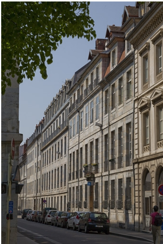
Logis principal, façade sur rue : de trois quarts droit. 25, Besançon, 16 rue de la Préfecture, lieudit : îlot Mairie
