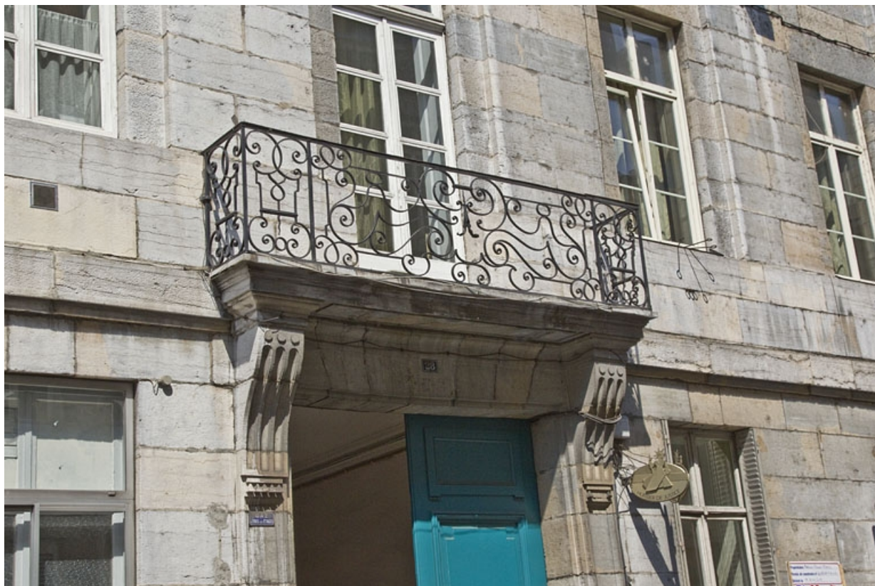
Logis principal, façade sur rue : détail du balcon.
