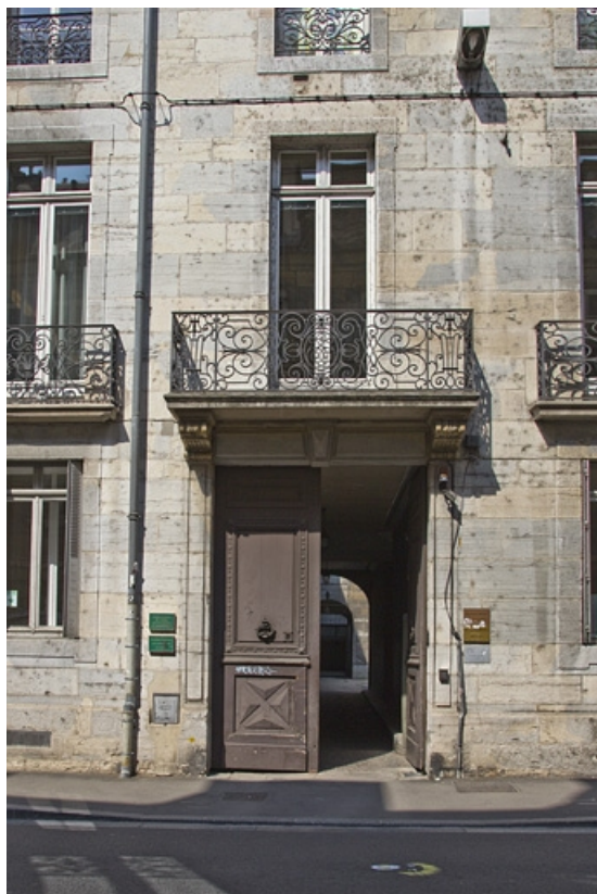
Logis principal, façade sur rue : détail du portail d'entrée.
