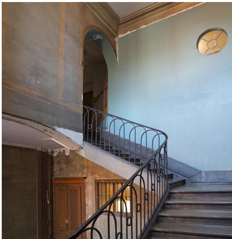
Logis principal, intérieur : détail de la partie supérieure de la cage d'escalier. 25, Besançon, 22 rue de la Préfecture, lieudit : îlot Mairie
