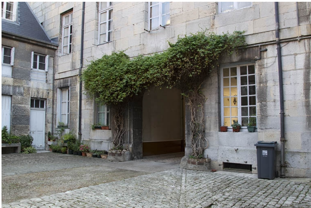
Logis principal, façade postérieure : détail du portail d'entrée dans la cour.
