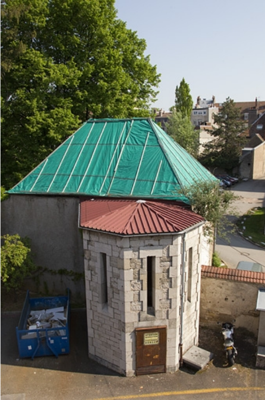
Pavillon de jardin : vue de la façade postérieure. 25, Besançon, 14 rue Mégevand, lieudit : îlot Mairie
