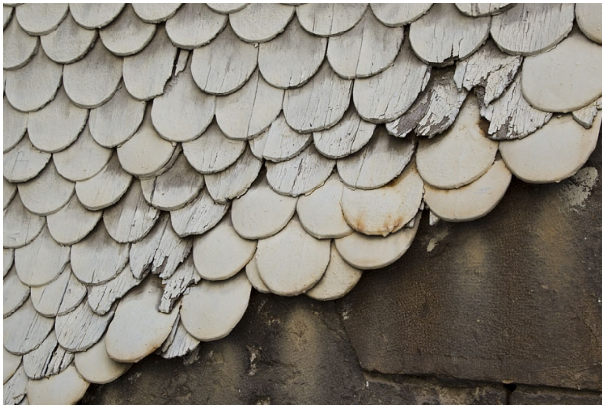
Détail des tavaillons recouvrant l'extérieur de la cage d'escalier : vue rapprochée.
