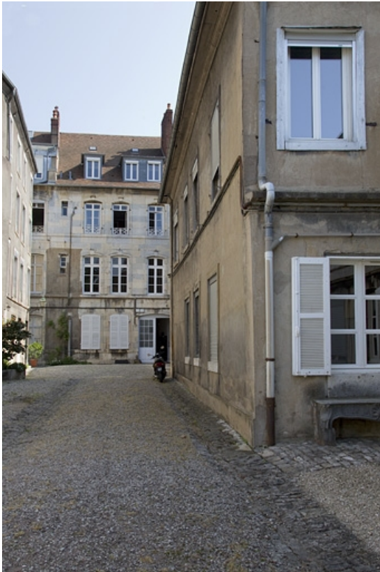
Vue d'ensemble des bâtiments depuis le fond de la cour.
