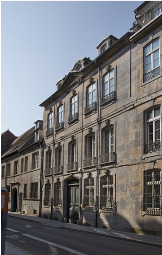
Logis principal, façade sur rue : de trois quarts droit, vue rapprochée.
