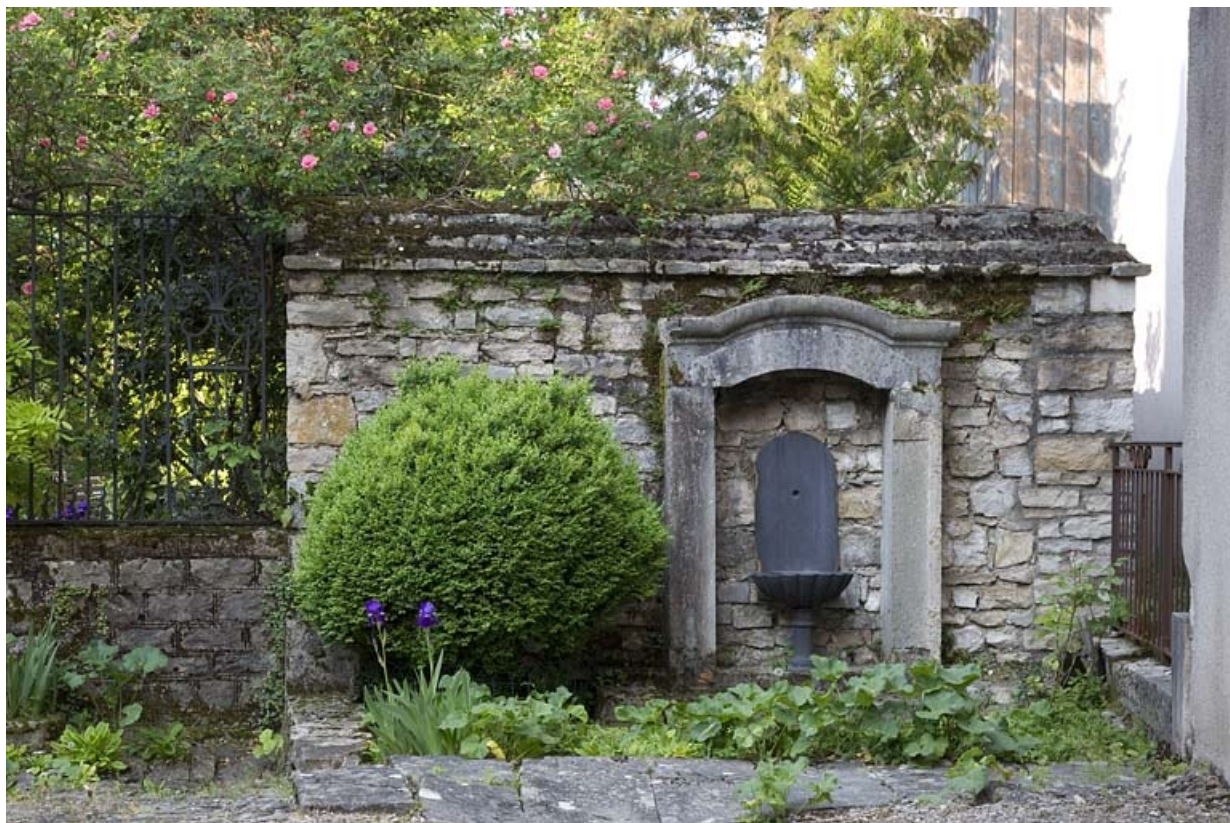
Vue de la borne-fontaine située contre le mur du jardin.
