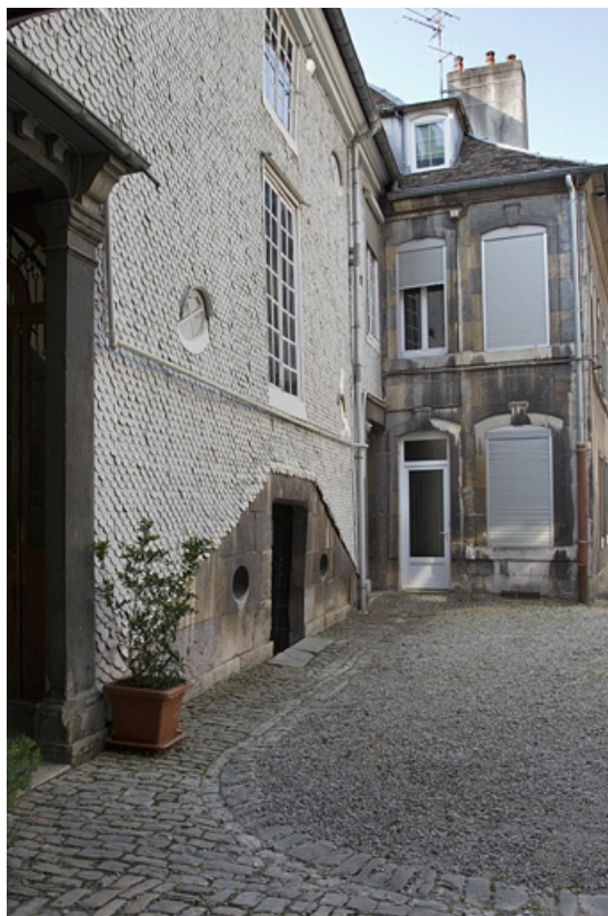
Vue de l'escalier à cage fermée et du premier logis secondaire, de trois quarts droit. 25, Besançon, 14 rue Mégevand, lieudit : îlot Mairie
