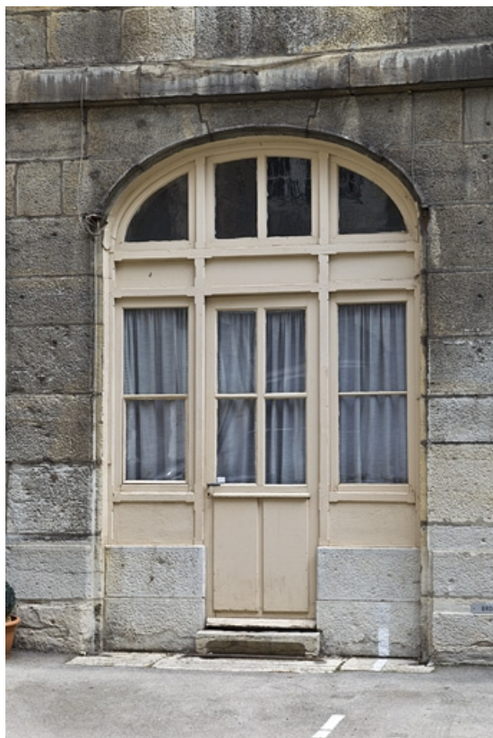
Bâtiment des remises : détail d'une baie du rez-de-chaussée.
