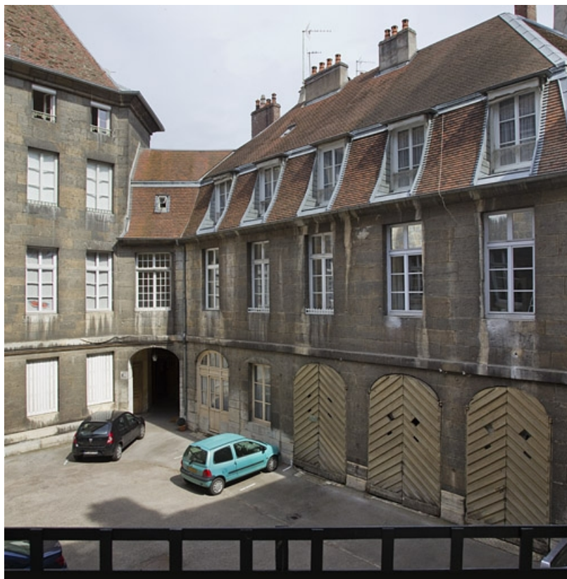
Bâtiment des remises : vue d'ensemble de trois quarts droit.
