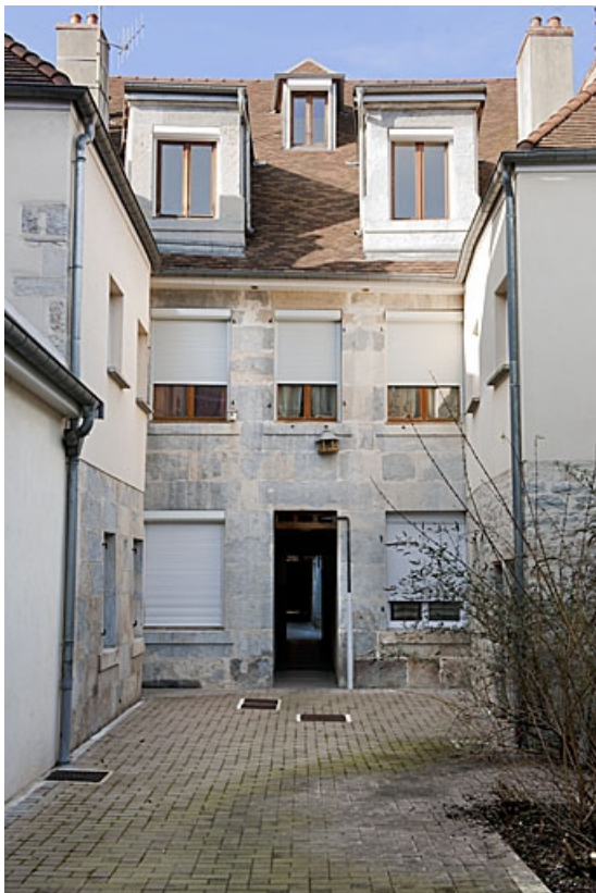
Premier logis secondaire : vue d'ensemble de la façade postérieure. 25, Besançon, 46 rue des Bersot, lieudit : îlot Jean Cornet
