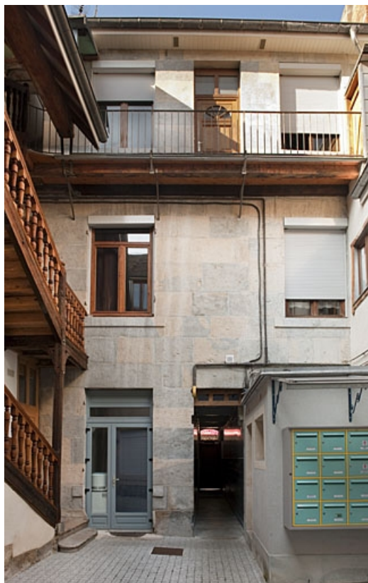
Logis principal : vue d'ensemble de la façade postérieure.
