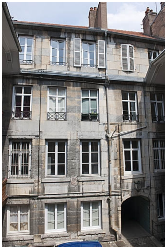
Premier logis secondaire : vue d'ensemble de la façade antérieure.
