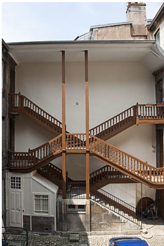
Vue d'ensemble de l'escalier à cage ouverte à gauche de la première cour, de face. 25, Besançon, 103 rue des Granges, lieudit : îlot Jean Cornet
