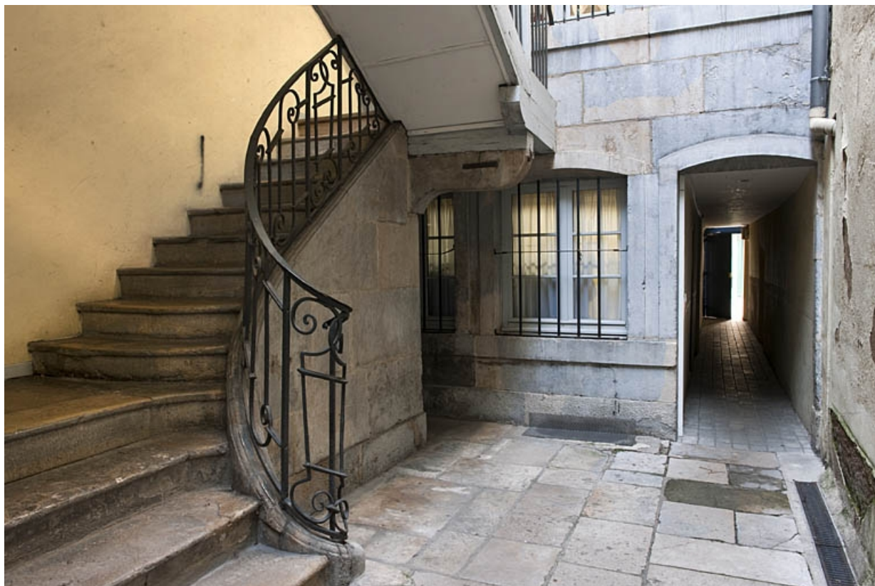
Départ de l'escalier à cage ouverte situé dans la première cour.
