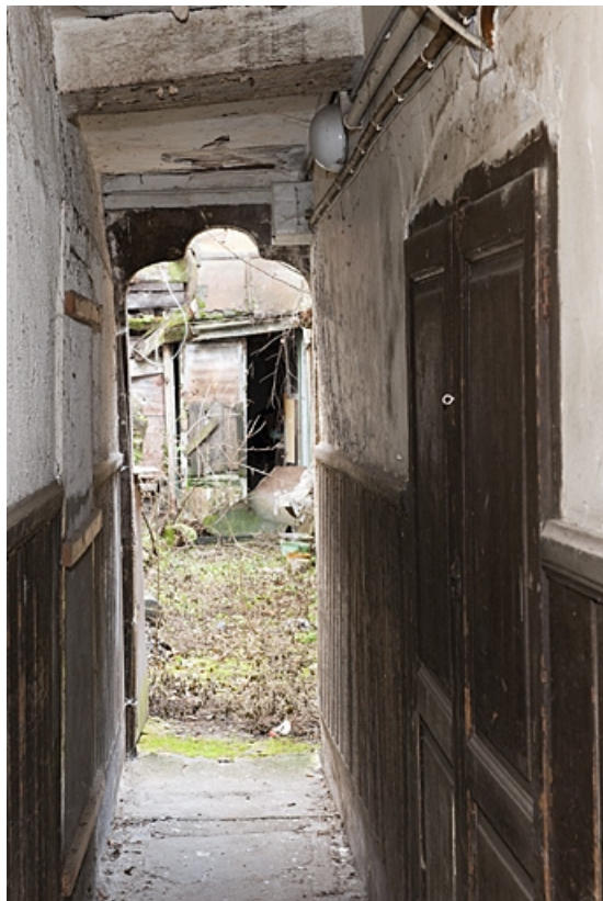
Logis principal : détail du couloir en direction de la cour.
