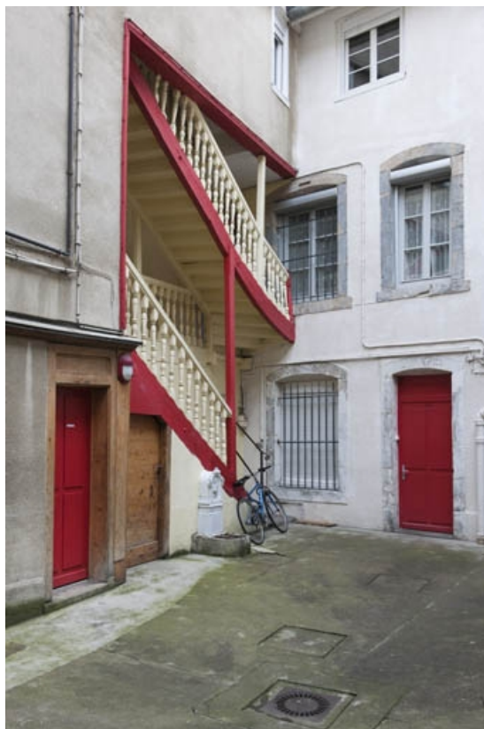
Premier logis secondaire : détail de l'escalier à cage ouverte situé à gauche de la première cour. 25, Besançon, 95 rue des Granges, lieudit : îlot Jean Cornet
