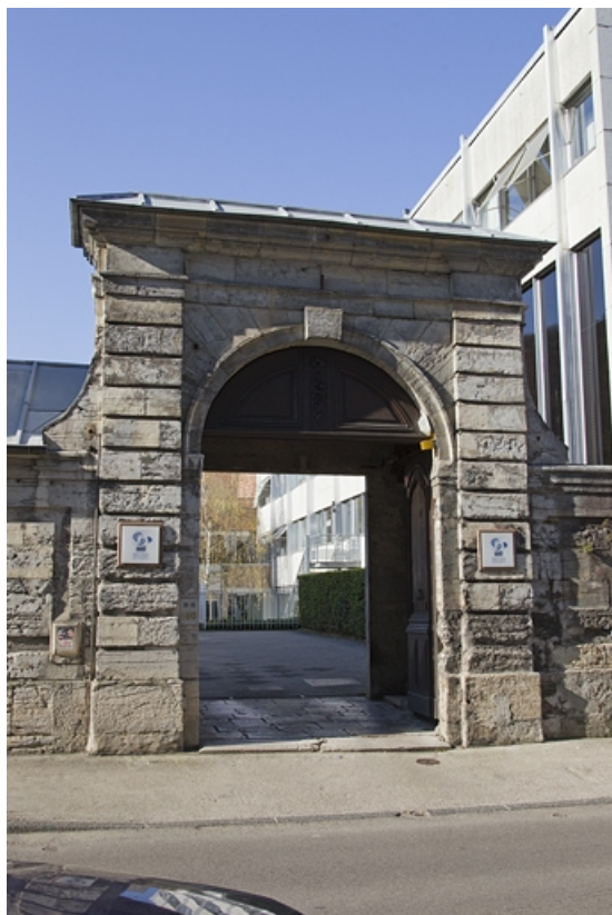
Vue d'ensemble du portail dans clôture, de face.
