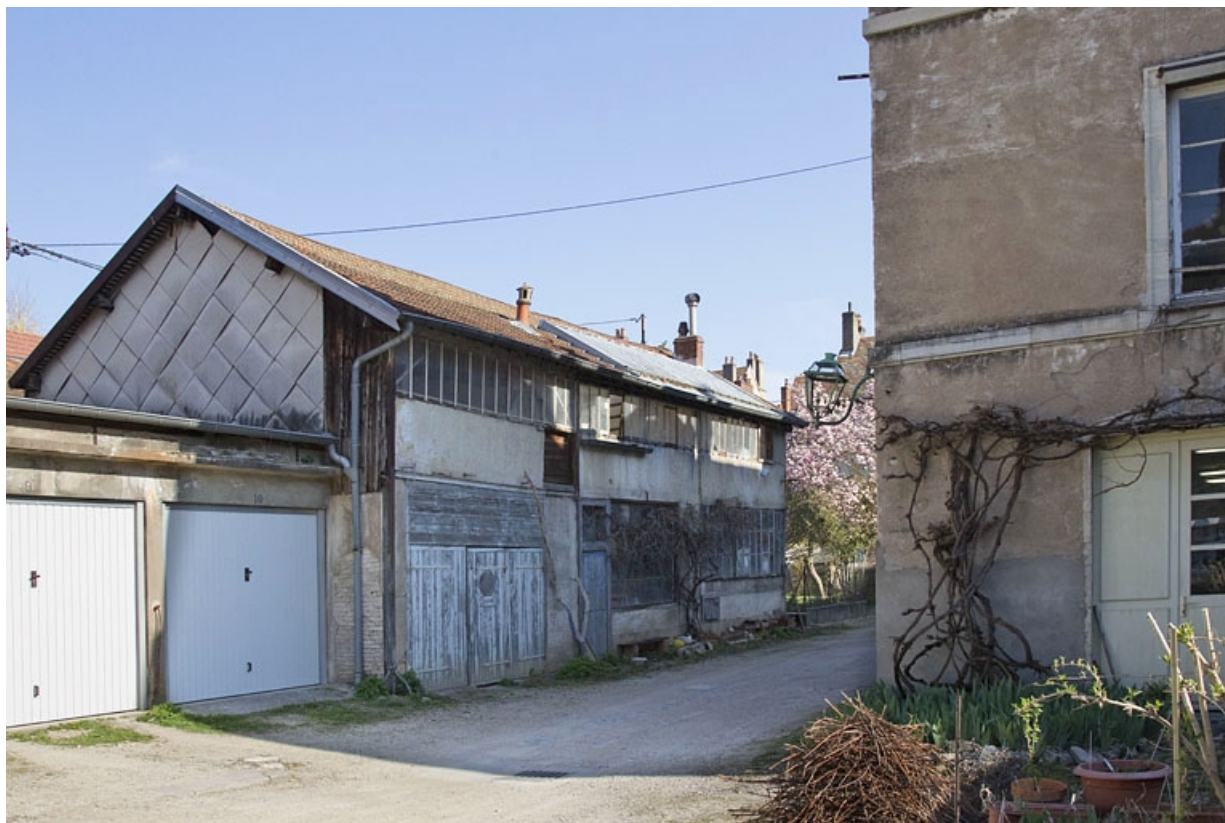
Vue d'ensemble de l'atelier, de trois quarts gauche.
