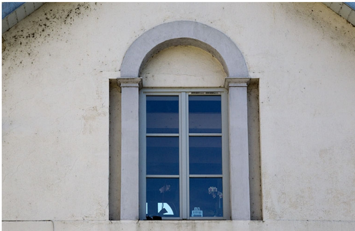
Logis secondaire au fond de la deuxième cour : façade donnant sur l'avenue de la Gare d'Eau, détail de la fenêtre de l'étage. 25, Besançon, 20 rue Charles Nodier, lieudit : îlot Préfecture
